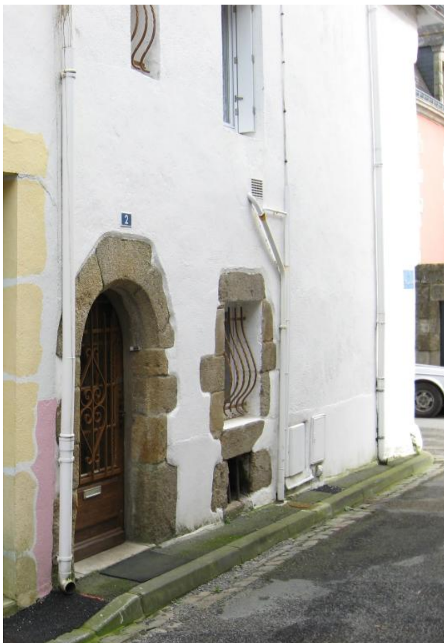
Porte d'entrée dans le mur gouttereau
