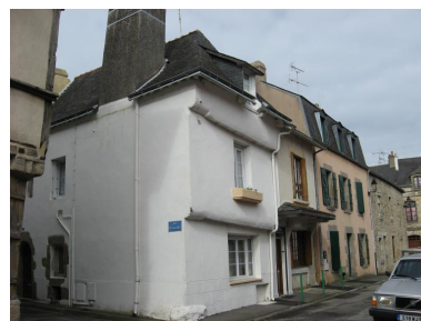
vue générale, façade sur rue, 2008 Phot. Pierre Laurent Constantin IVR53_20225605049NUCA
