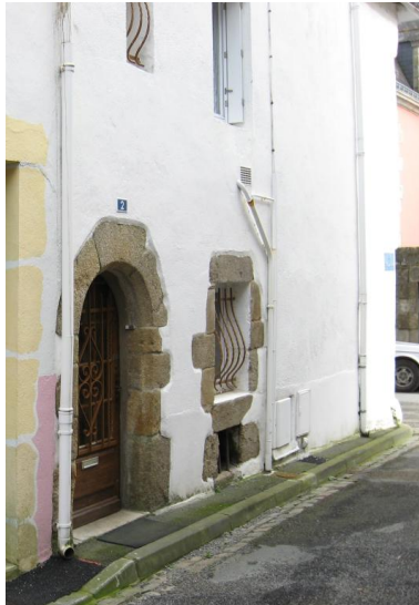
Porte d'entrée dans le mur gouttereau Phot. Pierre Laurent Constantin IVR53_20225605110NUCA
