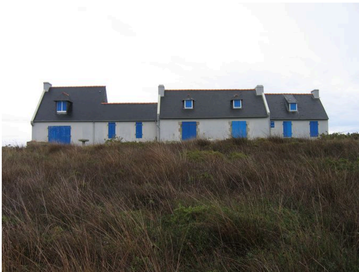
Vue côté mer de l'ancienne villa de Marcel Sauvaige
