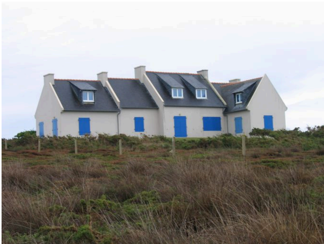
Vue côté mer de l'ancienne villa de Gustave Toudouze
