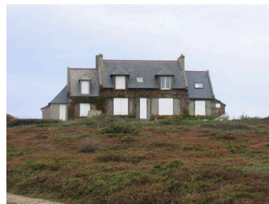
Vue côté terre de la seconde villa d'André Antoine Phot. Guillaume Marie IVR53_20062908462NUCA
