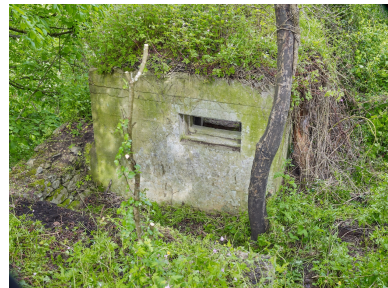
Vue du bunker adossé au parapet du mur ceinturant le Domaine de Cesson. L'embrasement en gradin est orientée vers le Nord-nord-ouest (vers le bunker - casemate de type 612) Phot. Bernard Bègne IVR53_20232200302NUCA
