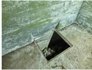
Vue de la niche aménagée dans le sol. Fermée par une trappe dont il subsiste la feuillure, cette niche permettait vraisemblablement de stocker des munitions (hypothèse) Phot. Bernard Bègne IVR53_20232200307NUCA
