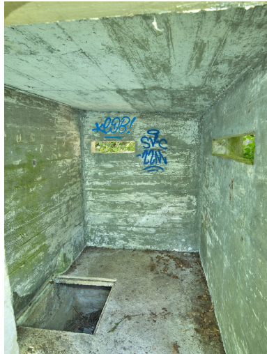
Vue intérieure des embrasures orientées vers le Nord-nord-ouest (vers le bunker - casemate de type 612) et vers l'Est-nord-est Phot. Bernard Bègne IVR53_20232200305NUCA
