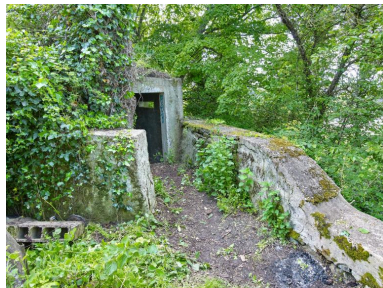
Vue générale depuis le Sud-sud-est : entrée. Un mur défensif en protège l'entrée : il est percé d'une ouverture de tir orientée vers l'intérieur de la pointe de Cesson (non visible sur la photographie). A droite, le parapet du mur ceinturant le domaine Phot. Bernard Bègne IVR53_20232200303NUCA
