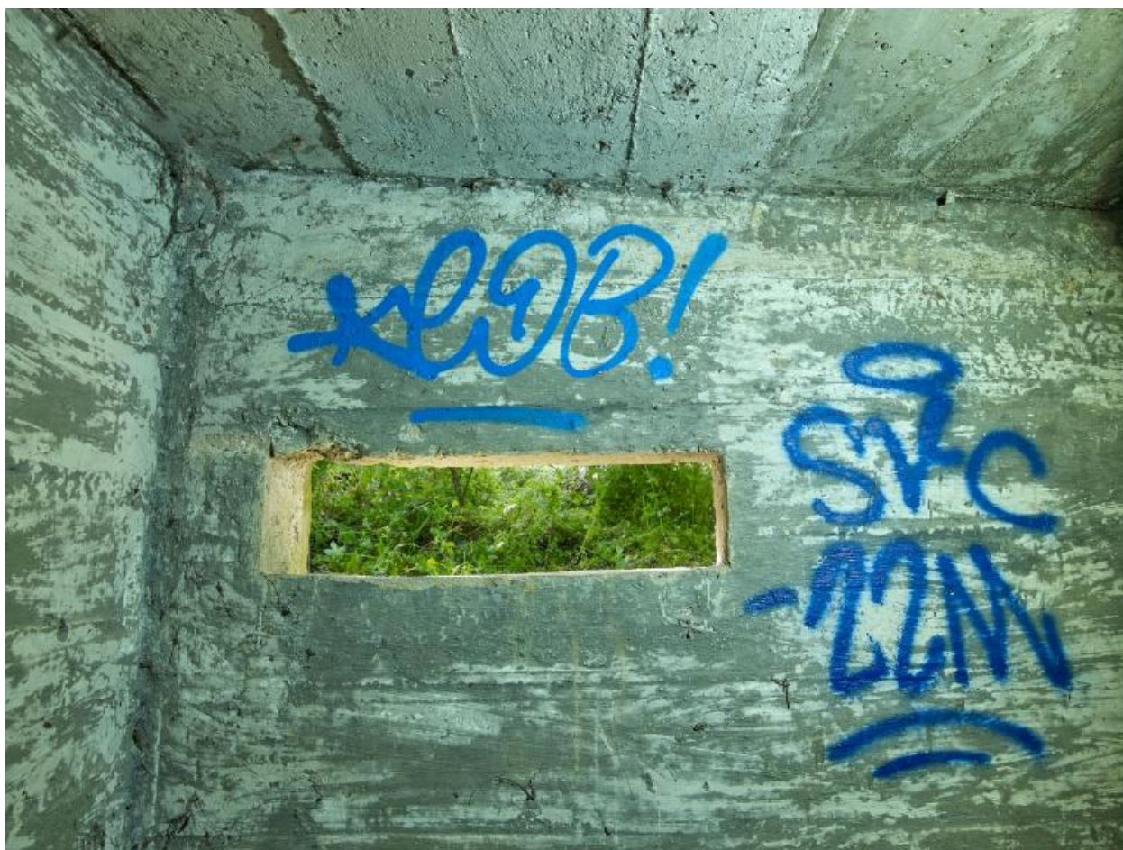
Vue intérieure de l'embrasure orientée vers le Nord-nord-ouest (vers le bunker - casemate de type 612)
