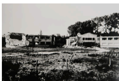
L'hospice de vieillards de la Chesnadière après les bombardements de juin 1944. La chapelle et l'aile droite semblent épargnées. On note la présence, au fronton de l'entrée, du haut-relief en plâtre représentant la Ville de Fougères, accueillant les vieillards IVR53_20203505003NUC
