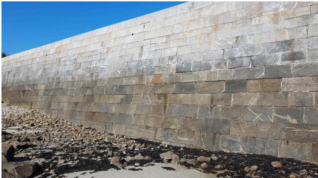
Môle, côté sud, maçonnerie pierres de taille (vue rapprochée)
