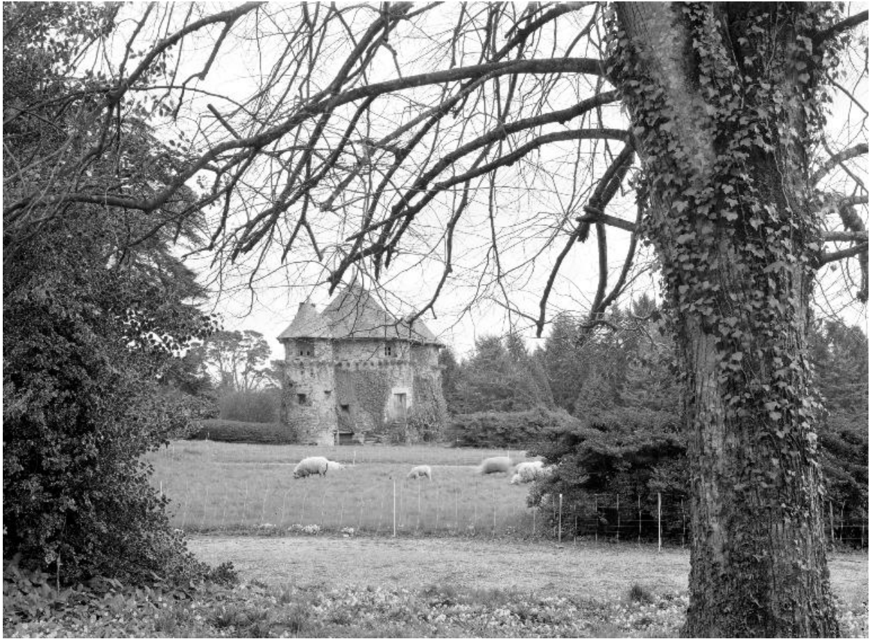
Château : tour nord-est (état en 1983)
