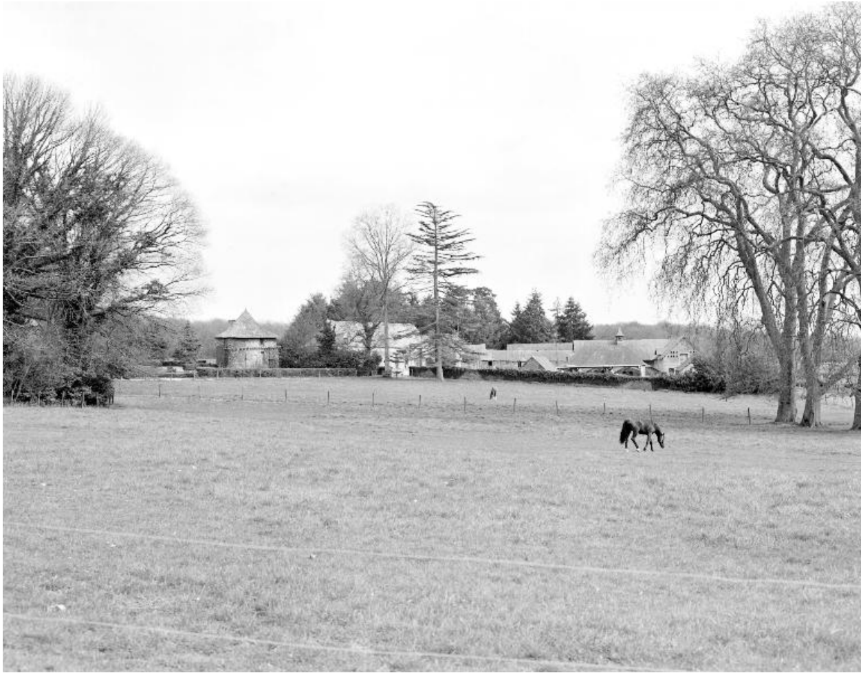
Château : tour sud-est vue du sud (état en 1983)
