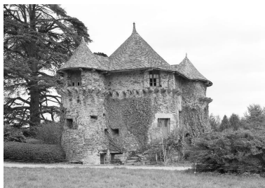
Château tour nord-est (état en 1983) Phot. Norbert Lambart IVR53_19835600447V
