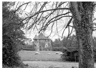
Château : tour nord-est (état en 1983) Phot. Norbert Lambart IVR53_19835600448V
