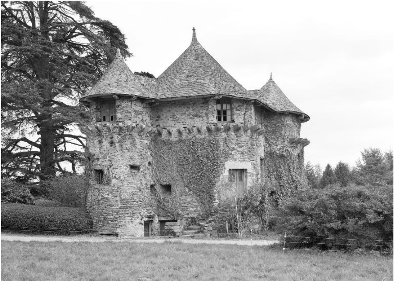
Château tour nord-est (état en 1983)
