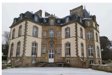
Elévation nord-ouest. (2021) Phot. Fabien Serre IVR53_20212906234NUCA
