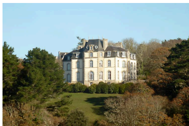
Vue générale ouest prise du pont d'Audierne. (2020) Phot. Fabien Serre IVR53_20202906187NUCA
