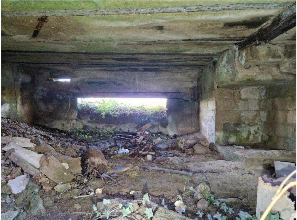
Vue intérieure : chambre de combat avec son embrasure et un petit créneau d'observation (à gauche). A droite, on peut voir le mode de construction du bunker en parpaing (Formstein)
