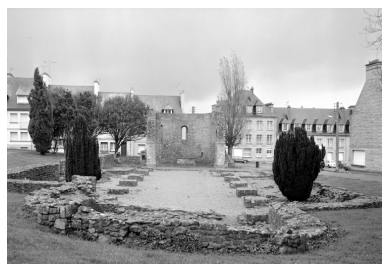
Vue générale des ruines de la cathédrale détruite
