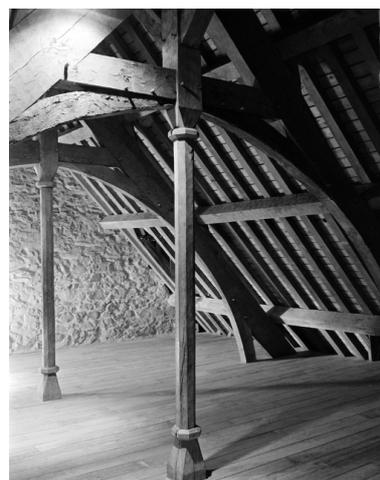
Vue de la charpente : partie nord-ouest (état en 1989). Le plancher est un ajout : à l'origine, le deuxième étage était sous charpente
