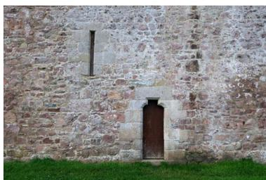
Vue de l'élévation postérieure côté Trieux : détail de la poterne (lindeau droit sur coussinets en pierre de taille de granite). Le grand jour vertical éclaire l'escalier en vis sud. La maçonnerie est en en moellon de grès rose ou rougeâtre
