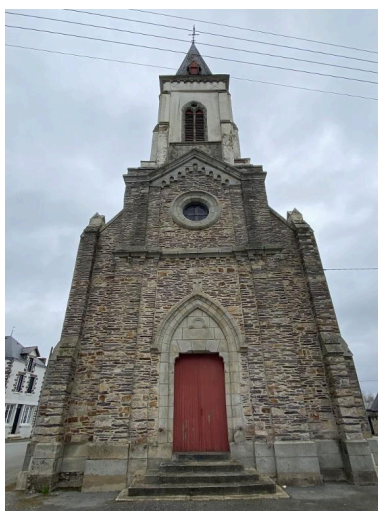
Vue ouest Phot. Baptiste Oligo IVR53_20255611071NUCA
