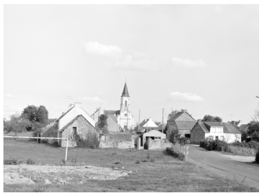
Église : vue de situation ouest (état en 1983) Phot. Guy Artur, Phot. Norbert Lambart IVR53_19845600019X
