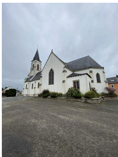
Vue sud-est Phot. Baptiste Oligo IVR53_20255611070NUCA
