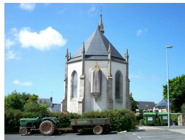
Plouider, chapelle Notre-Dame-des-Malades : élévation est Phot. Gwénaél Fauchille IVR53_20082906298NUCA
