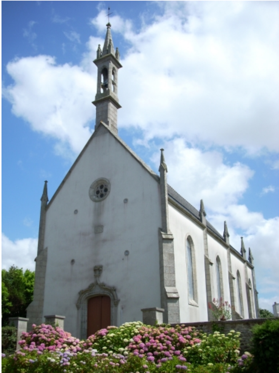
Plouider, chapelle Notre-Dame-des-Malades : vue générale sud-ouest
