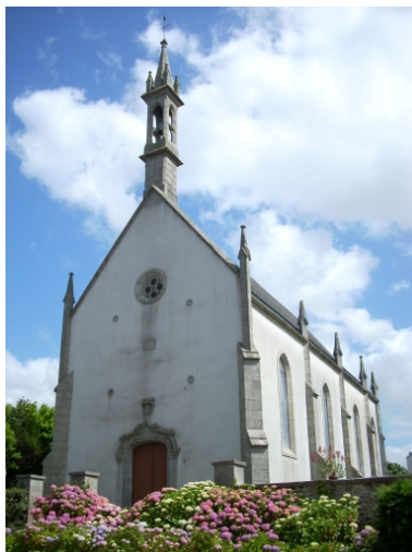
Plouider, chapelle Notre-Dame-des-Malades : vue générale sud-ouest Phot. Gwénaél Fauchille IVR53_20082906297NUCA
