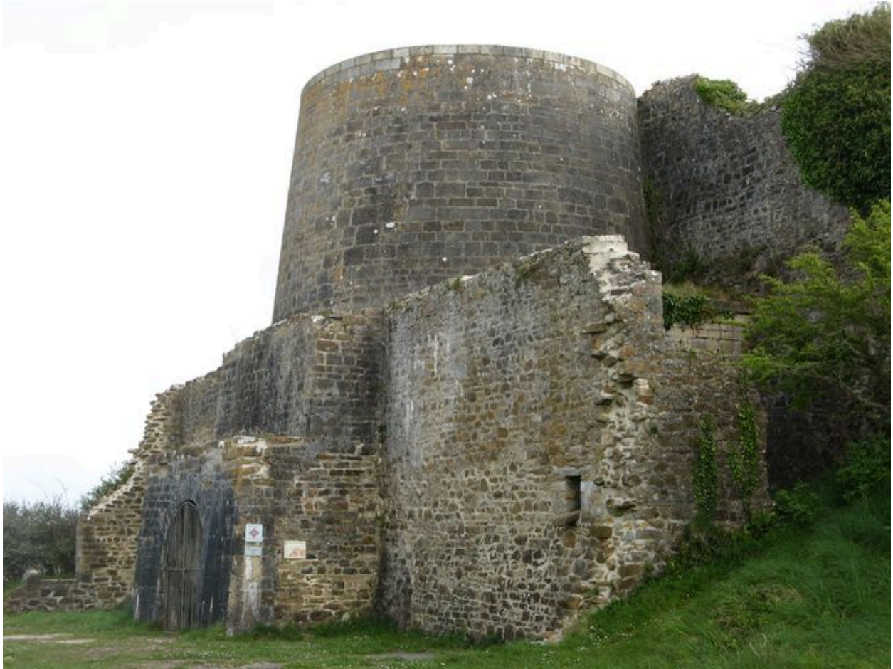
Vue sud du four à chaux de Rozan
