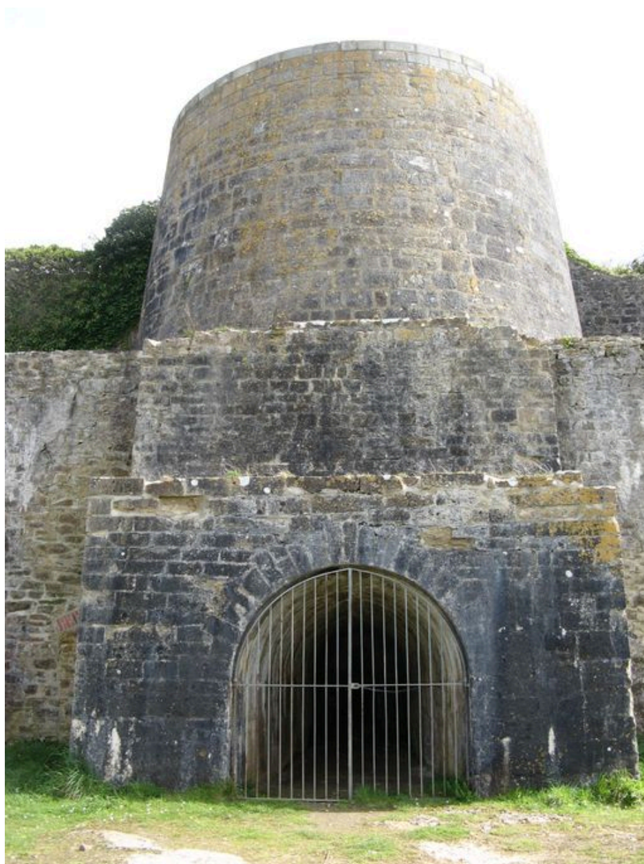
Détail du four à chaux de Rozan
