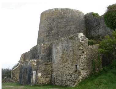
Vue sud du four à chaux de Rozan Phot. Guillaume Marie IVR53_20082908334NUCA
