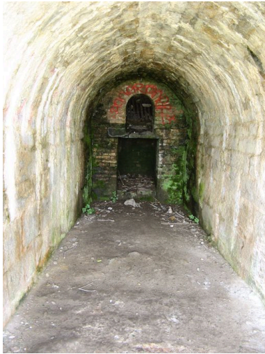
Vue intérieure du four à chaux de Rozan Phot. Guillaume Marie IVR53_20082908335NUCA
