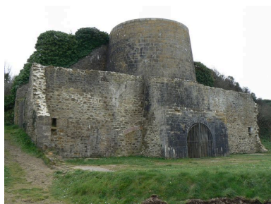
Vue générale de la motte féodale de Rozan transformée en four à chaux Phot. Julien Amghar IVR53_20072908900NUCA
