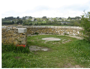
Gueulard du four à chaux de Rozan Phot. Guillaume Marie IVR53_20082908337NUCA
