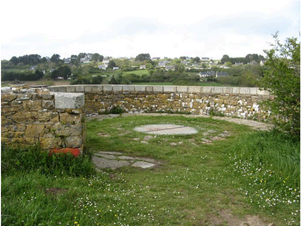
Gueulard du four à chaux de Rozan
