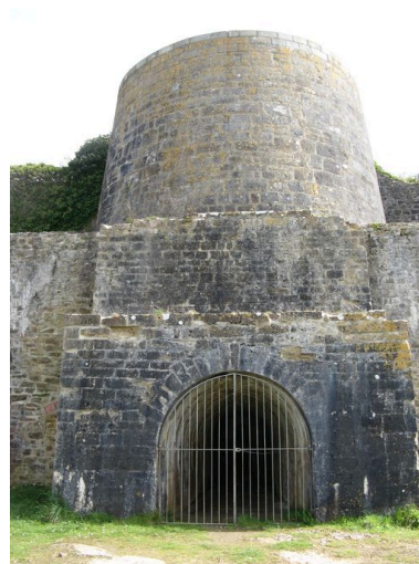
Détail du four à chaux de Rozan Phot. Guillaume Marie IVR53_20082908336NUCA
