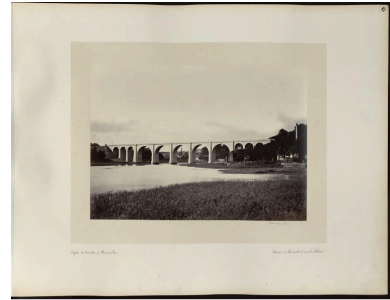
Le viaduc à Hennebont IVR53_20225605740NUCA
