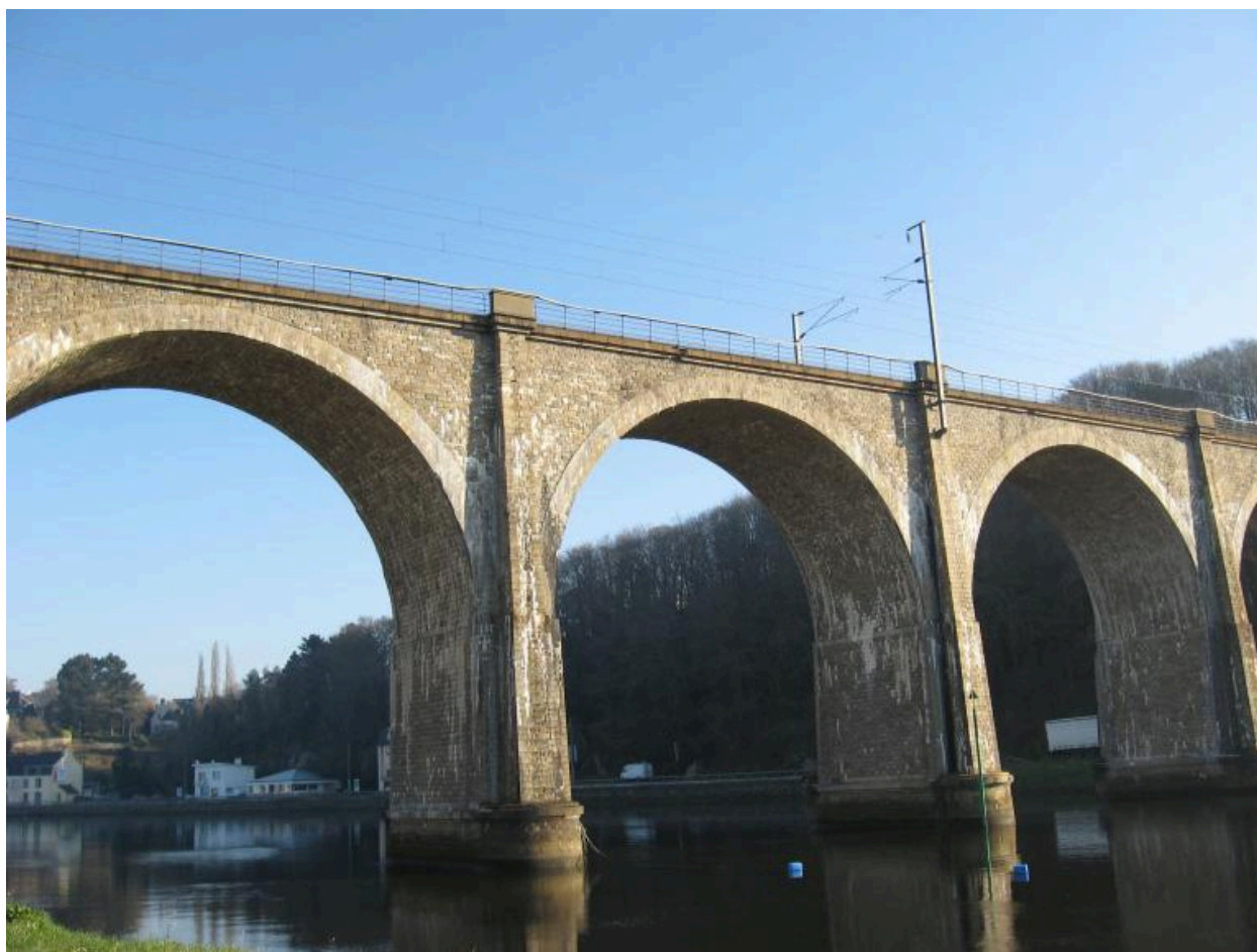
Le viaduc, vue de l'aval
