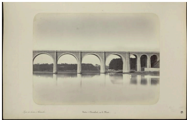
Viaduc d'Hennebont Phot. Jules Duclos IVR53_20225605741NUCA
