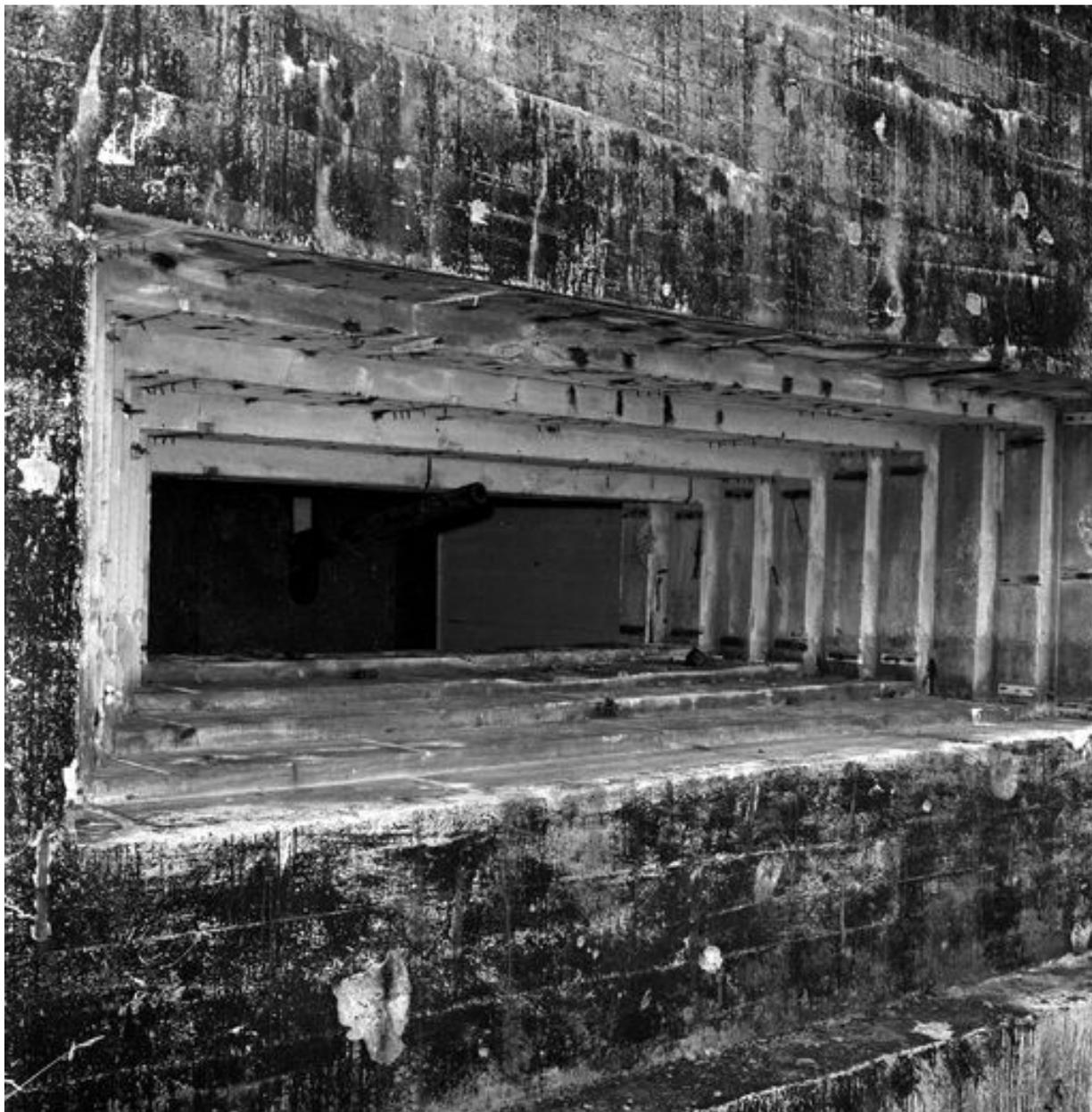
Vue de l'une des deux embrasures bétonnées (état en 1969). L'embrasure se caractérise par son ébrasement extérieur à redans conçu pour éviter les coups d'embrasure
