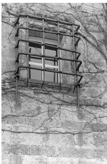
Vue de détail de la grille de la fenêtre. Phot. François Dagorn IVR53_19683500109V
