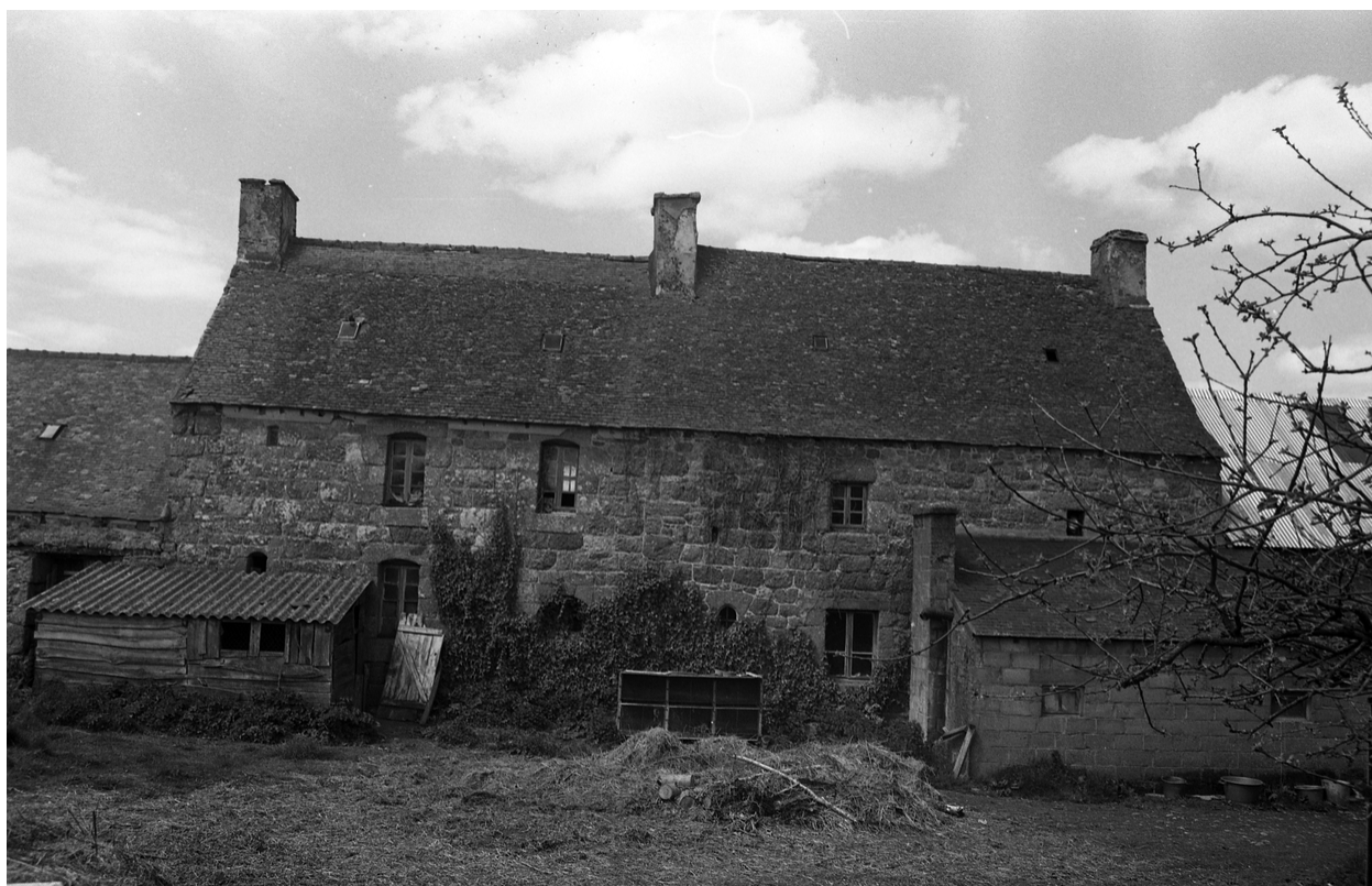
Vue générale de la façade nord
