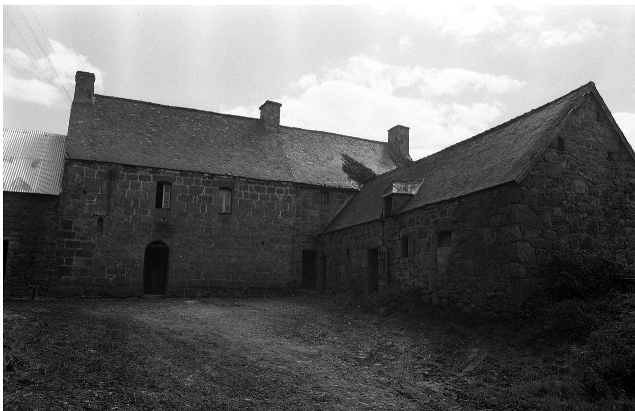
Vue générale de la façade sud
