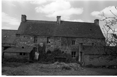
Vue générale de la façade nord Phot. Jean-Pierre Boucher, Phot. Catherine Toscer IVR53_19742205215Z
