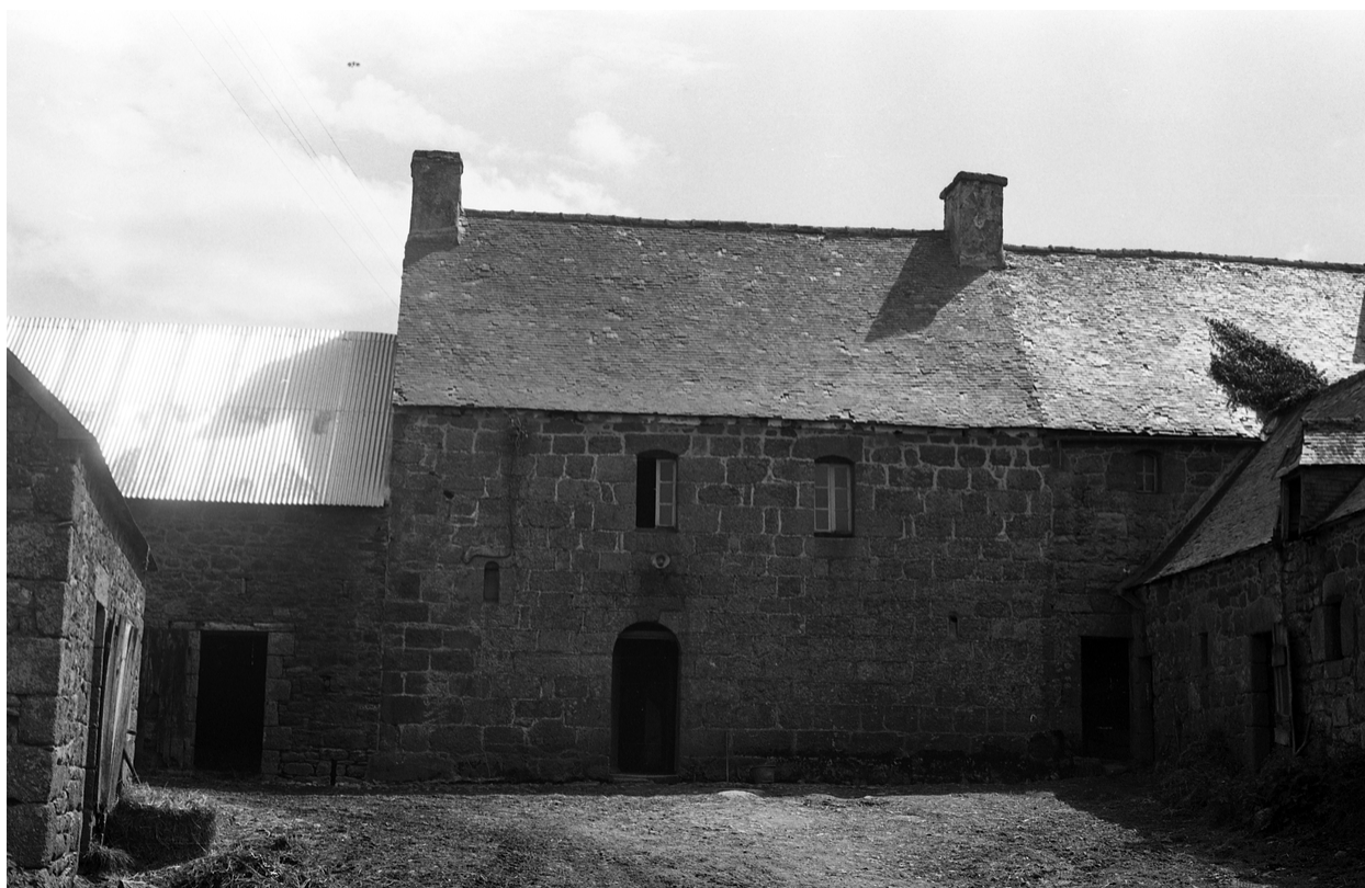
Vue générale de la façade sud
