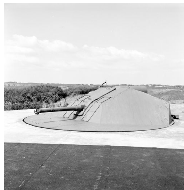
Vue de l'un des quatre canons antiaériens de 10,5 cm sous blindage (état en 1969). Le blindage est de type en calotte sphérique Phot. Guy Artur IVR53_19692900097X
