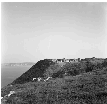
Vue d'ensemble (état en 1969). Quatre canons antiaériens de 10,5 cm sous blindage sont en place Phot. Guy Artur, Phot. Norbert Lambart IVR53_19692900089X
