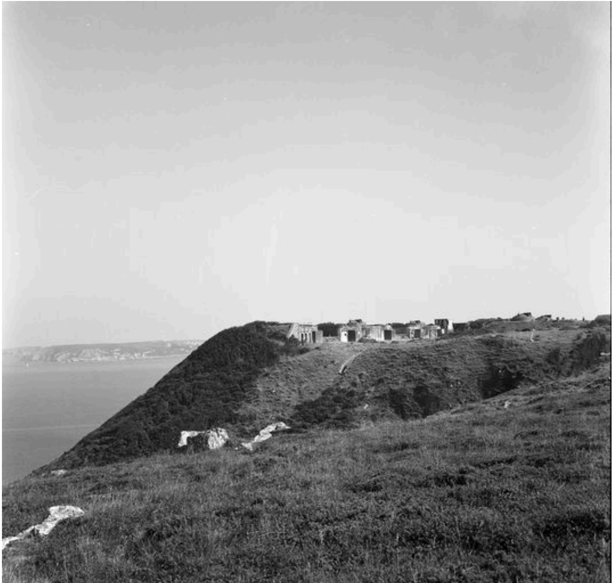
Vue d'ensemble (état en 1969). Quatre canons antiaériens de 10,5 cm sous blindage sont en place
