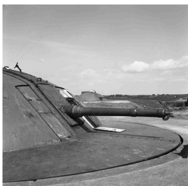
Vue de l'un des quatre canons antiaériens de 10,5 cm sous blindage (état en 1969). Le blindage est de type en calotte sphérique Phot. Guy Artur, Phot. Norbert Lambart IVR53_19692900085X
