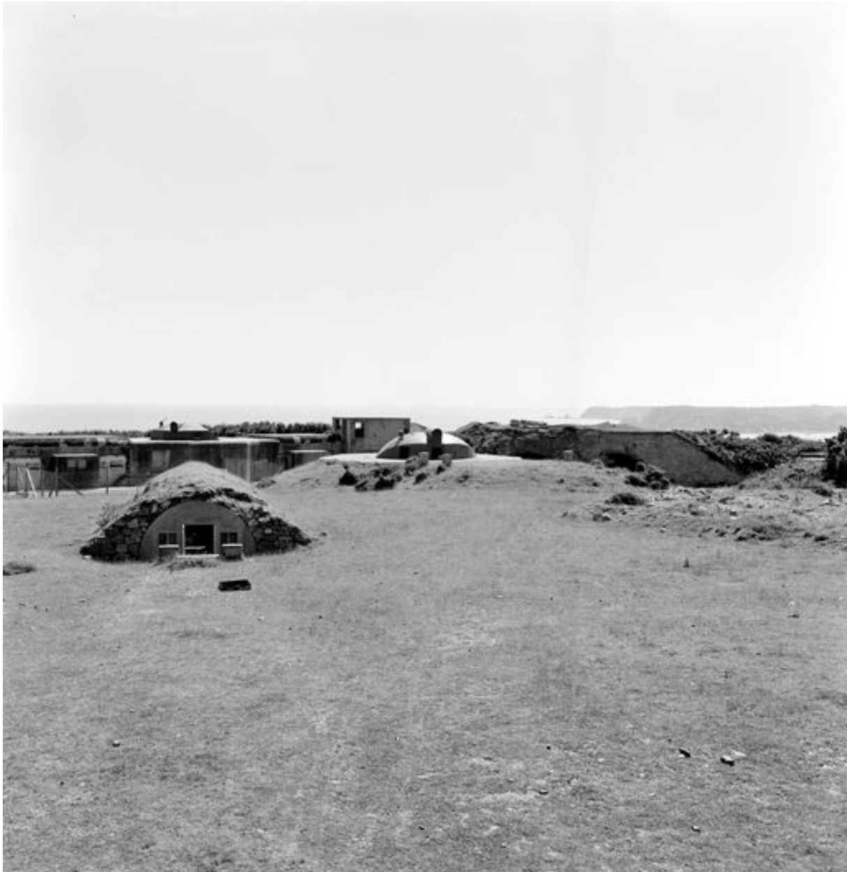
Vue d'ensemble (état en 1969). Deux des quatre canons antiaériens de 10,5 cm sous blindage sont visibles
