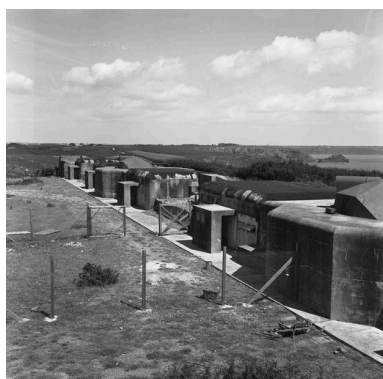
Vue d'ensemble (état en 1969). Deux des quatre canons antiaériens de 10,5 cm sous blindage sont visibles Phot. Guy Artur, Phot. Norbert Lambart IVR53_19692900084X
