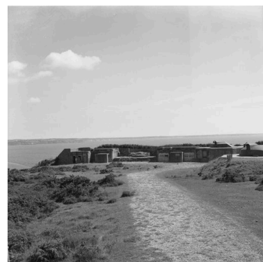
Vue d'ensemble (état en 1969). Deux des quatre canons antiaériens de 10,5 cm sous blindage sont visibles Phot. Guy Artur, Phot. Norbert Lambart IVR53_19692900090X
