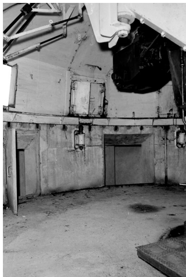
Vue de l'un des quatre canons antiaériens de 10,5 cm sous blindage (état en 1969) Phot. A. Le Bihan, Phot. Norbert Lambart IVR53_19692900338Z
