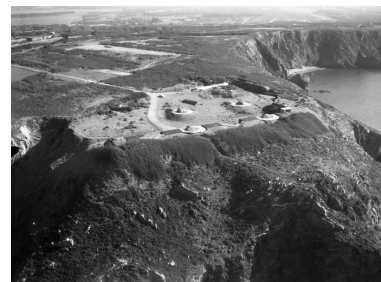
Vue aérienne oblique, 1971. Quatre canons antiaériens de 10,5 cm sous blindage sont en place Phot. Guy Artur, Phot. Norbert Lambart IVR53_19712900547P
