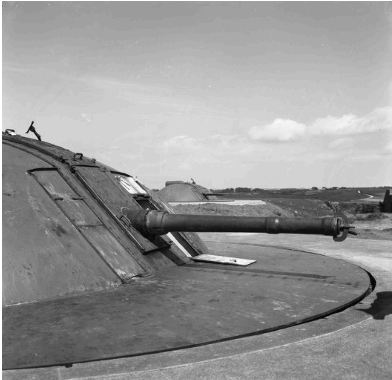
Vue de l'un des quatre canons antiaériens de 10,5 cm sous blindage (état en 1969). Le blindage est de type en calotte sphérique
