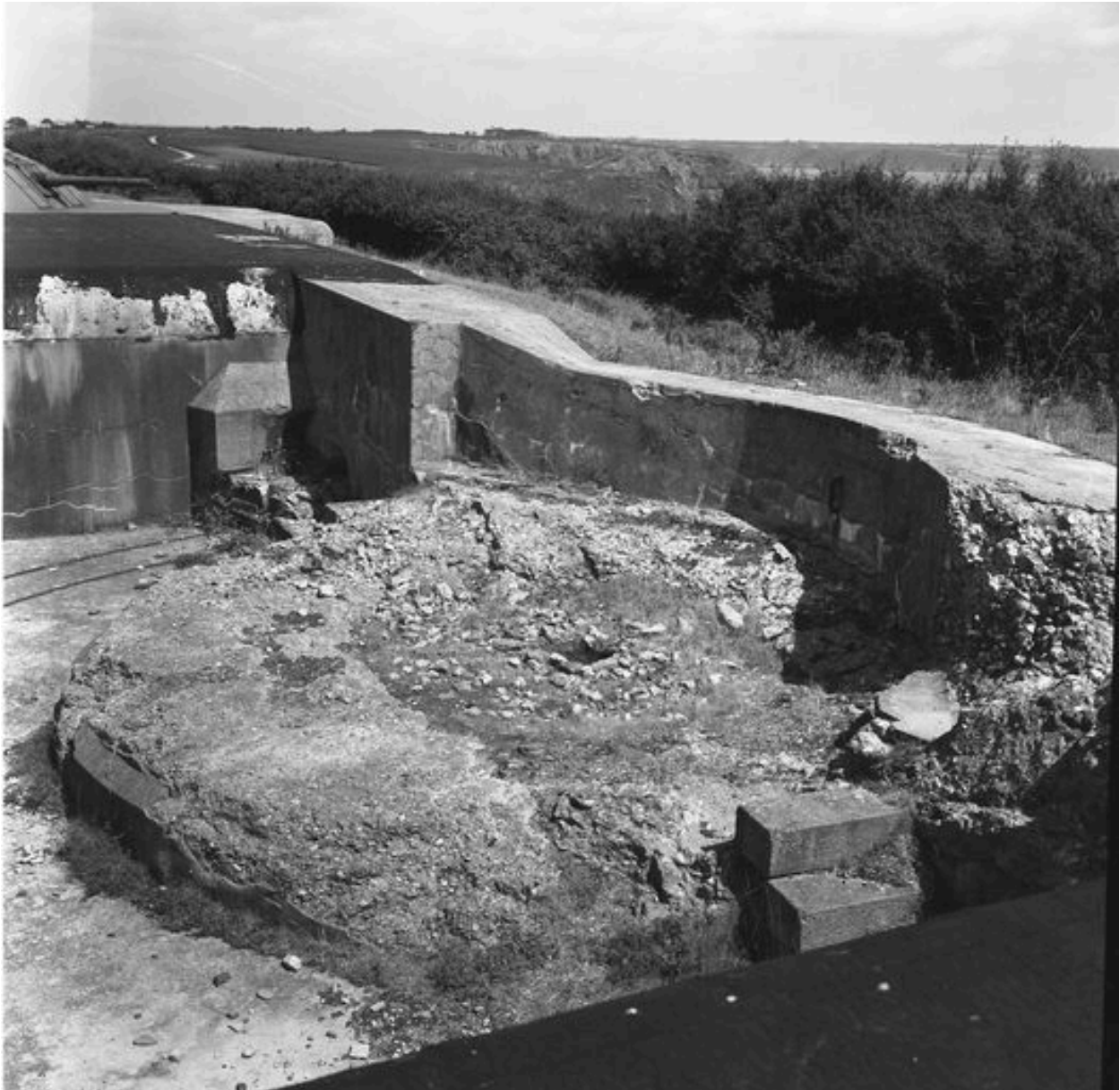
Vue de l'un des emplacements pour canon de 24 cm (état en 1969)
