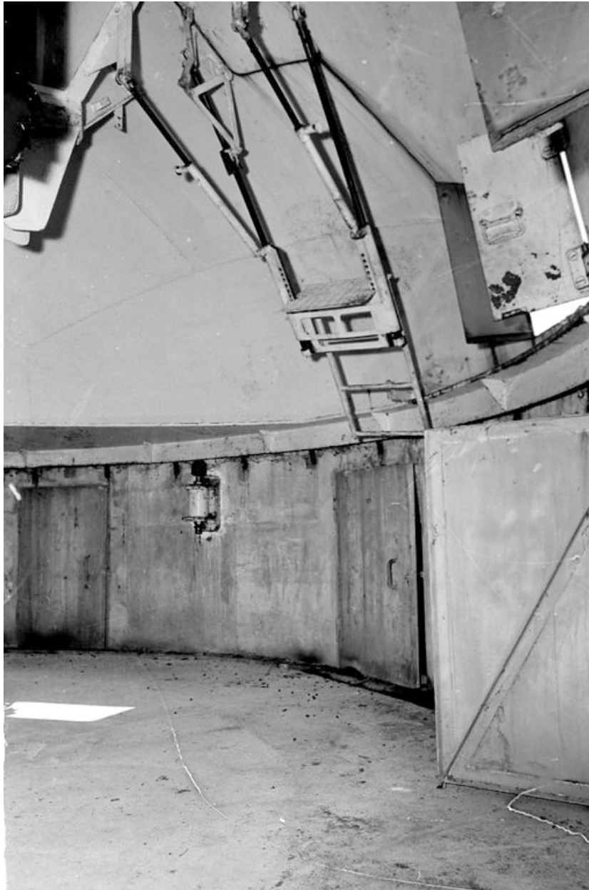
Vue de l'un des quatre canons antiaériens de 10,5 cm sous blindage (état en 1969)
