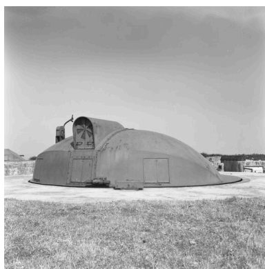
Vue de l'un des quatre canons antiaériens de 10,5 cm sous blindage (état en 1969). Le blindage est de type en calotte sphérique Phot. Guy Artur, Phot. Norbert Lambart IVR53_19692900086X
