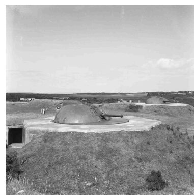
Vue de deux des quatre canons antiaériens de 10,5 cm sous blindage (état en 1969) Phot. Guy Artur, Phot. Norbert Lambart IVR53_19692900087X
