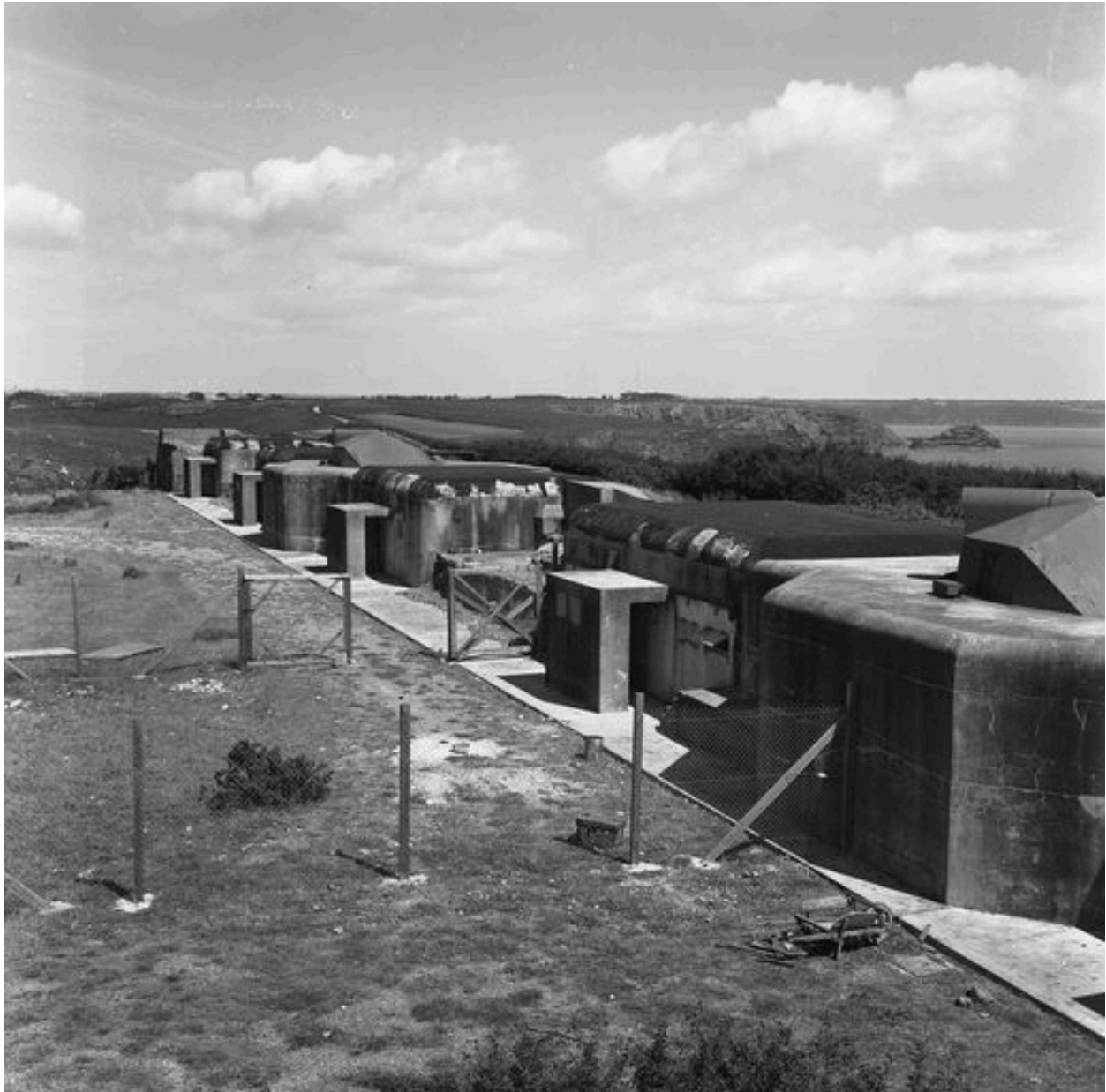
Vue d'ensemble (état en 1969). Deux des quatre canons antiaériens de 10,5 cm sous blindage sont visibles
