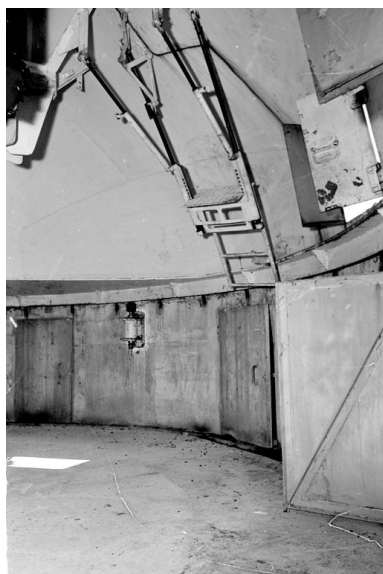
Vue de l'un des quatre canons antiaériens de 10,5 cm sous blindage (état en 1969) Phot. A. Le Bihan, Phot. Norbert Lambart IVR53_19692900341Z
