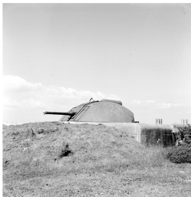
Vue de l'un des quatre canons antiaériens de 10,5 cm sous blindage (état en 1969). Le blindage est de type en calotte sphérique Phot. Guy Artur IVR53_19692900098X
