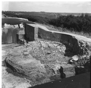
Vue de l'un des emplacements pour canon de 24 cm (état en 1969) Phot. Guy Artur, Phot. Norbert Lambart IVR53_19692900083X
