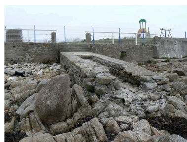
Rampe du fort de Locqueltas Phot. Julien Amghar IVR53_20085606024NUCA
