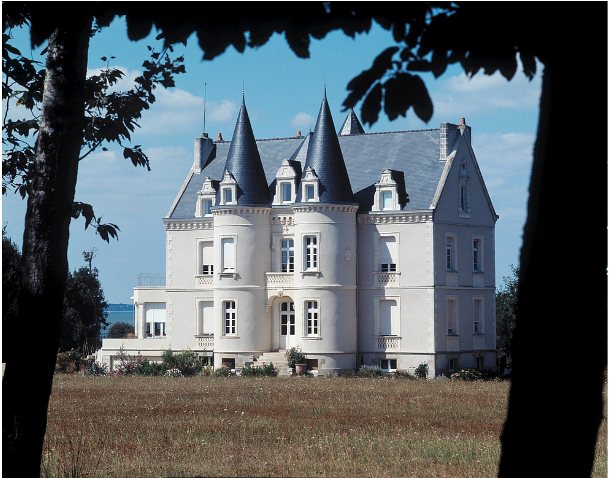
Château, élévation sud.
