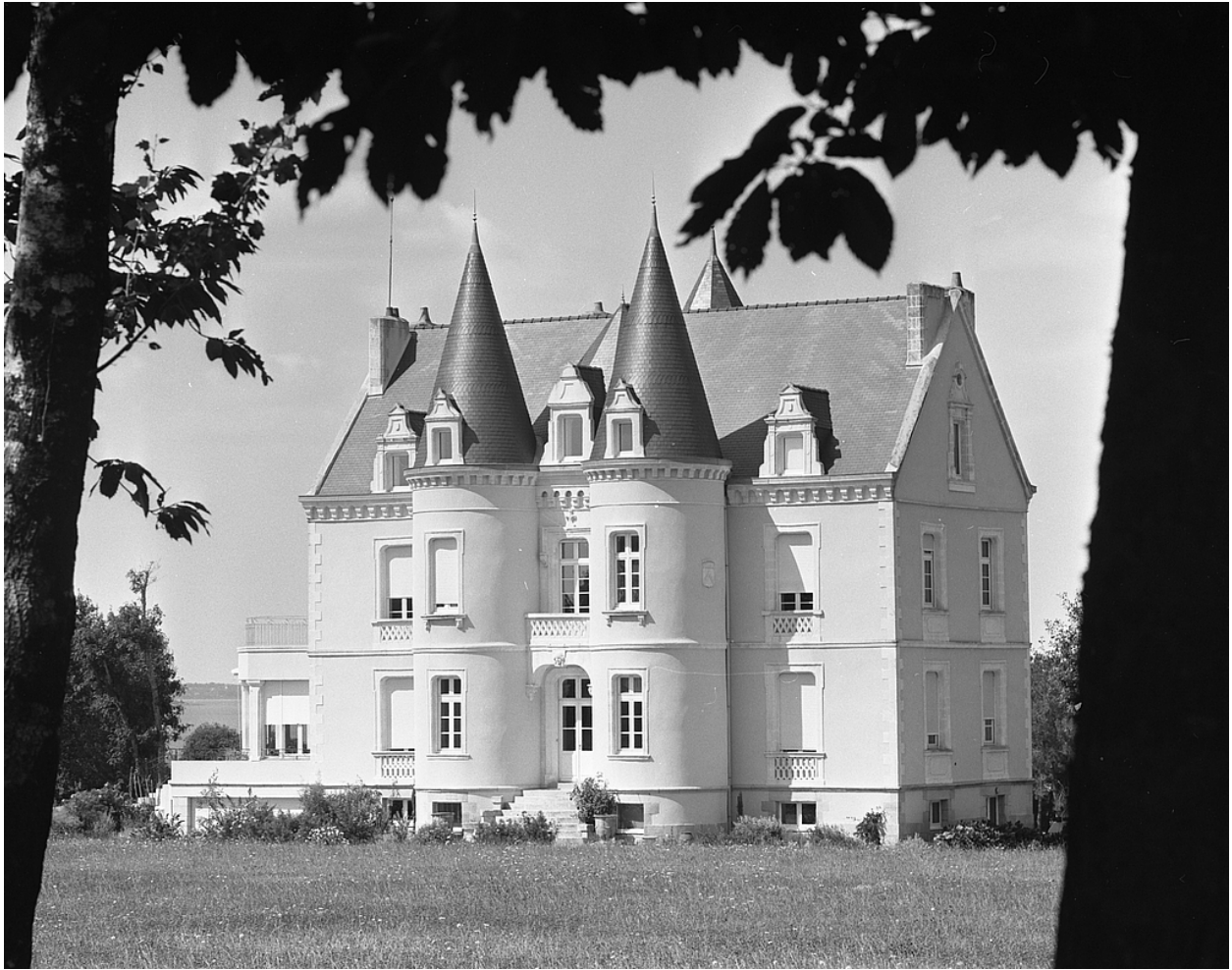
Château, élévation sud.
