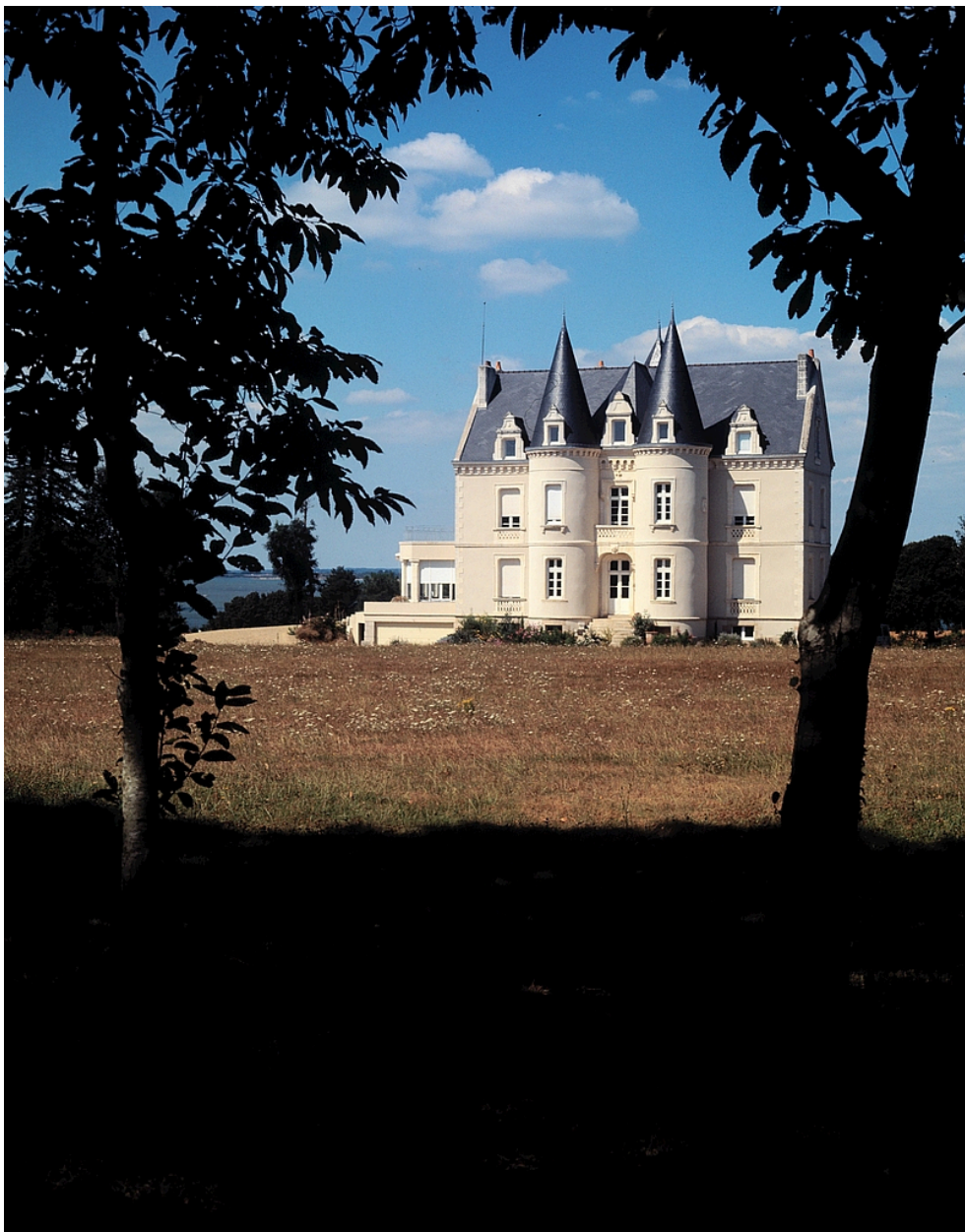
Château, vue générale sud.
