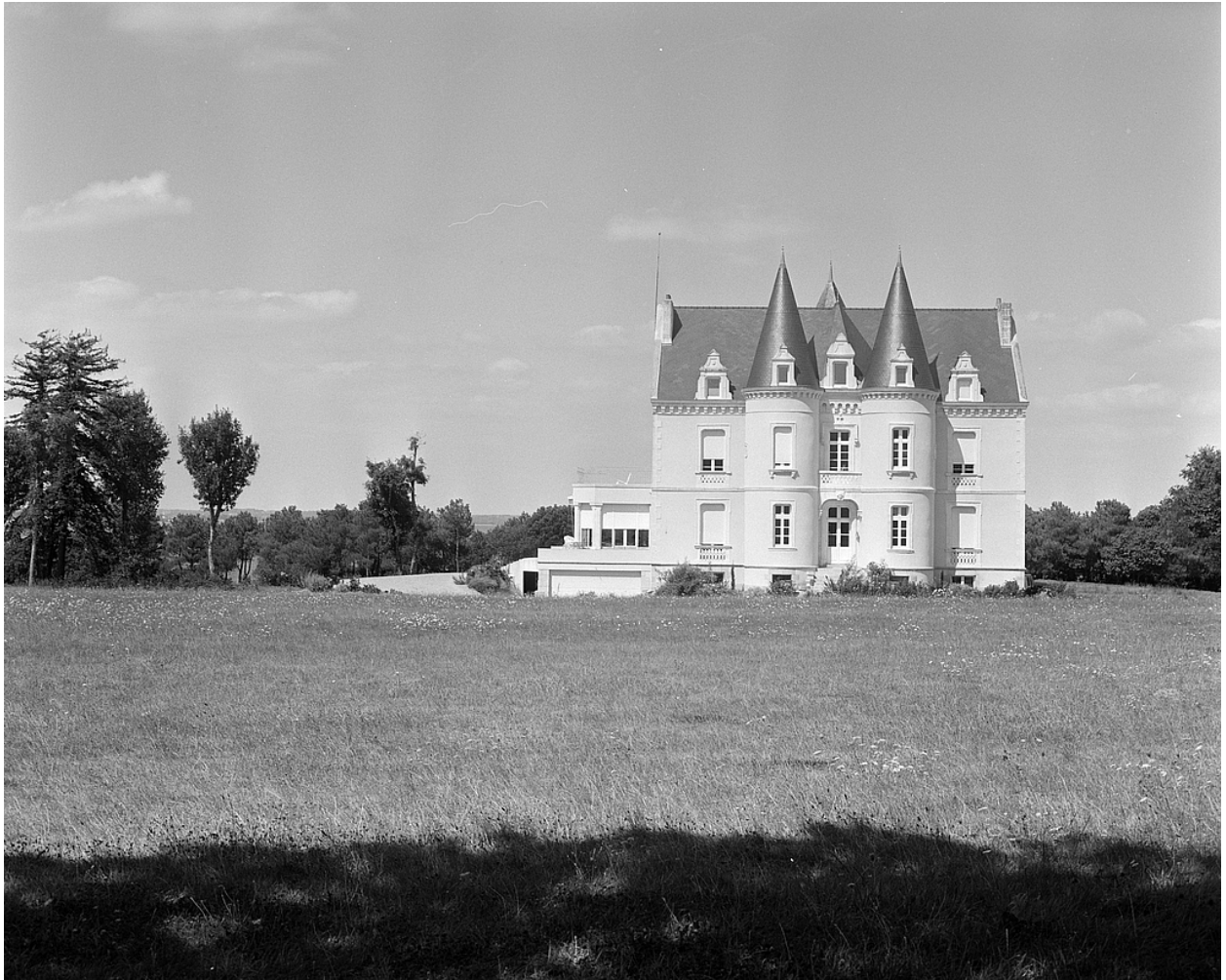
Château, vue générale sud.
