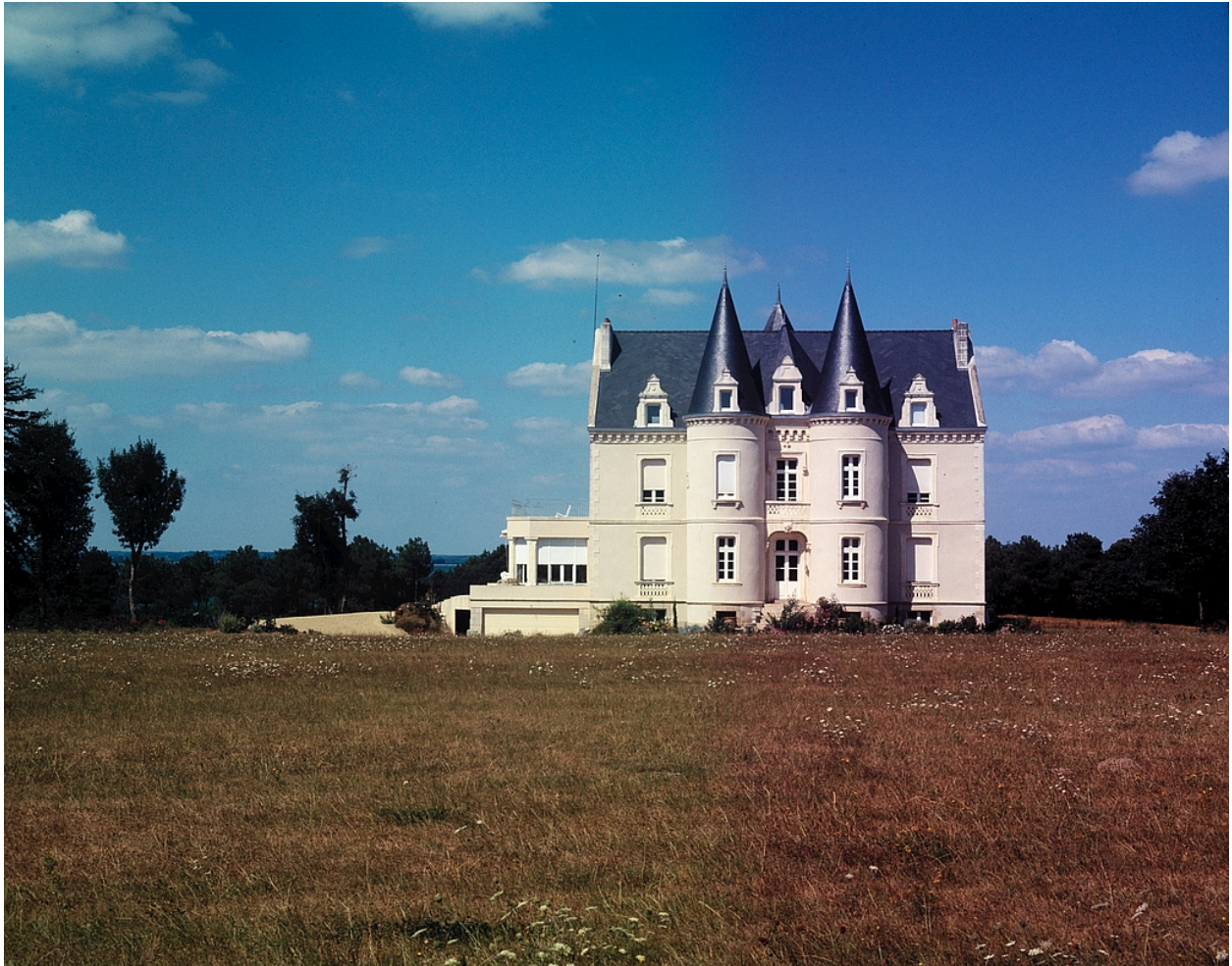
Château, vue générale sud.
