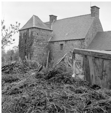
Façade nord prise d'ouest (état en 1974). Phot. Norbert Lambart, Autr. Marie Berthou IVR53_19902200520X
