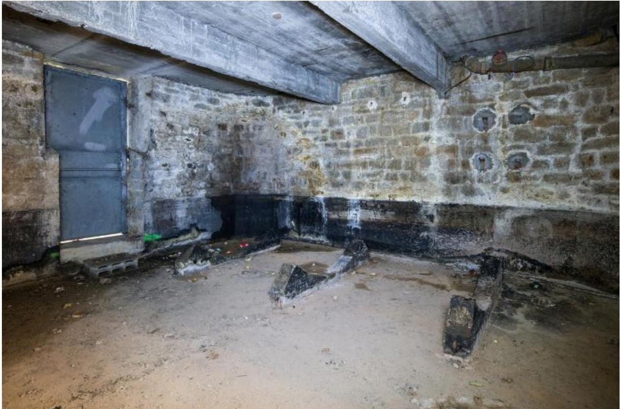
Vue du sous-sol en 2019. Emplacement d'une ancienne cuve ; plafond en béton armé et murs porteurs en granite.
