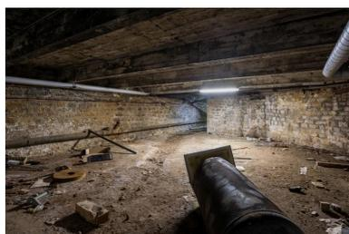
Vue du sous-sol : plafond en béton armé et murs porteurs en granite.
