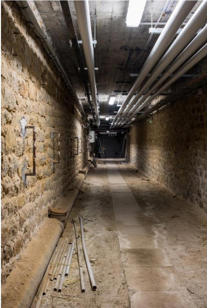
Vue du sous-sol en 2019. Noter l'usage pour les réseaux, le plafond en béton armé et les murs porteurs en granite.
