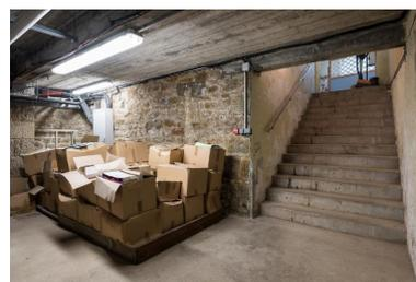
Sous-sol : plafond et escalier en béton armé ; murs porteurs en granite.
