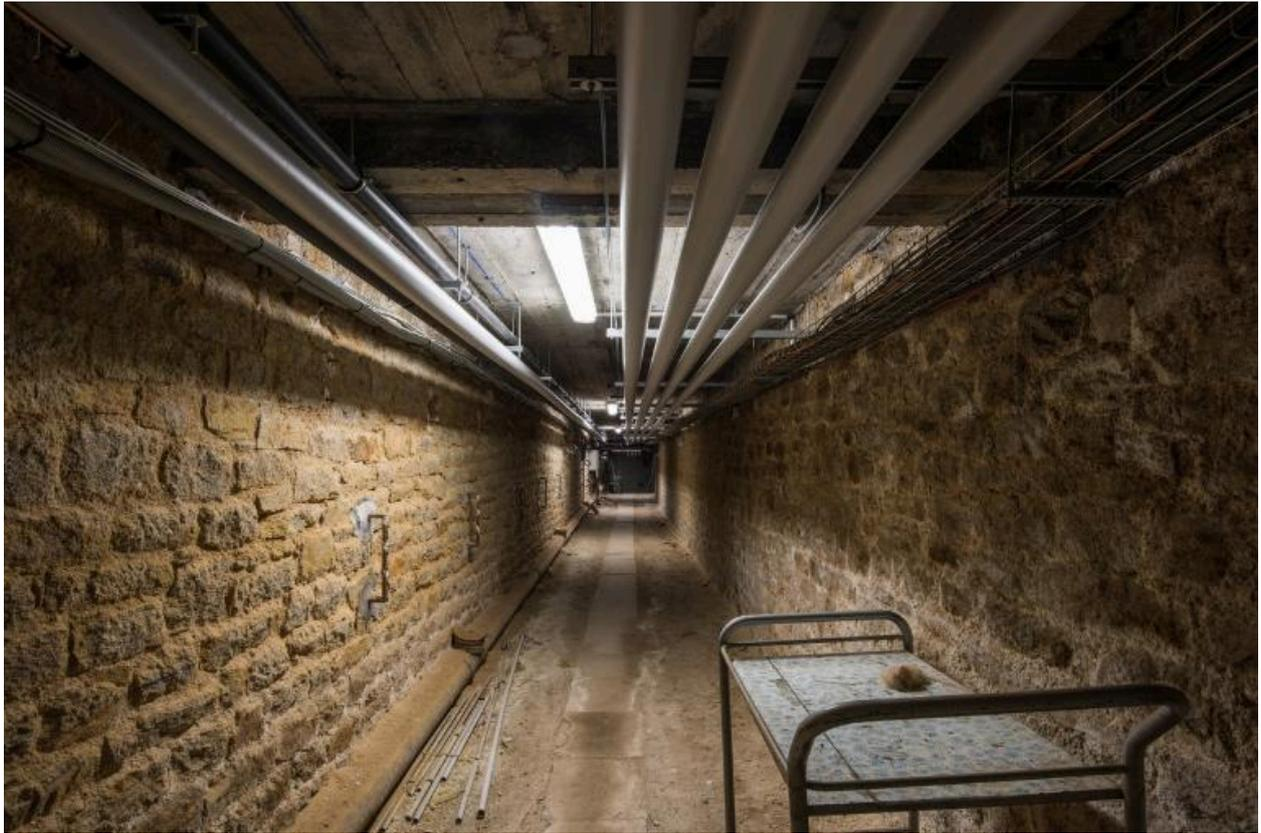
Vue du sous-sol en 2019. Noter l'usage pour les réseaux, le plafond en béton armé et les murs porteurs en granite.
