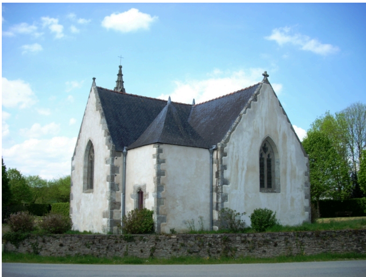
Collorec, chapelle Sainte-Marguerite : vue générale sud-est
