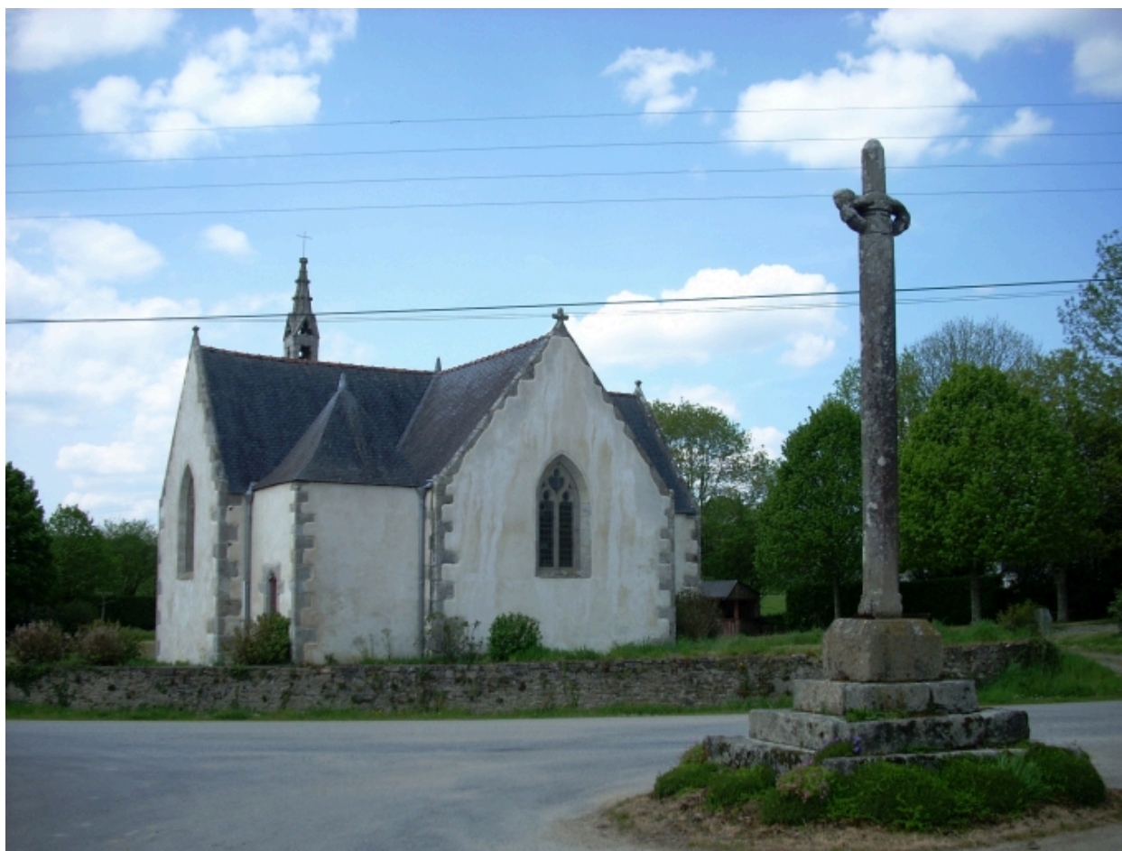
Collorec, chapelle Sainte-Marguerite : vue générale sud-est
