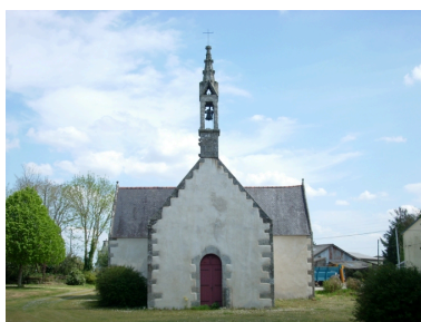
Collorec, chapelle Sainte-Marguerite : élévation ouest Phot. Gwénaél Fauchille IVR53_20082905823NUCA
