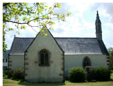
Collorec, chapelle Sainte-Marguerite : élévation nord Phot. Gwénaél Fauchille IVR53_20082905824NUCA
