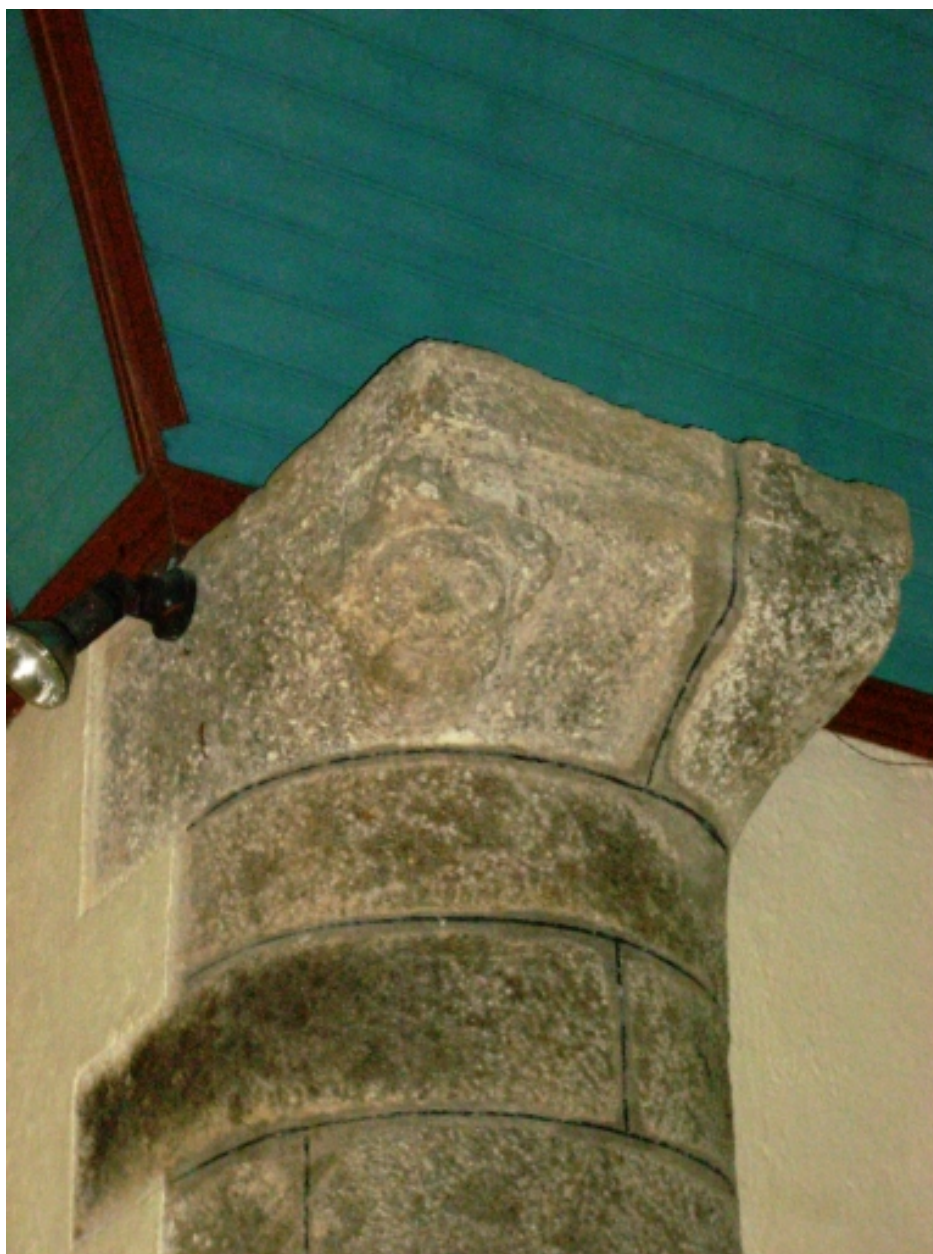
Collorec, chapelle Sainte-Marguerite : détail colonne engagée à l'angle nord-ouest
