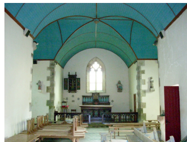
Collorec, chapelle Sainte-Marguerite : vue axiale est Phot. Gwénaél Fauchille IVR53_20082905826NUCA
