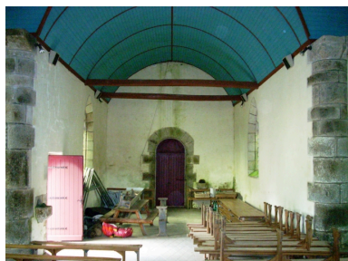
Collorec, chapelle Sainte-Marguerite : vue axiale ouest Phot. Gwénaél Fauchille IVR53_20082905827NUCA
