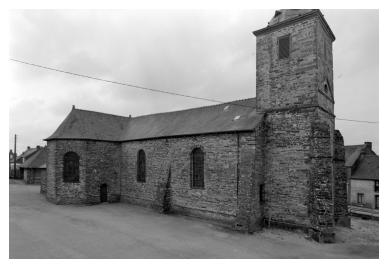
Elévation Nord : vue générale Phot. Guy Artur, Phot. Norbert Lambart IVR53_19943501025X
