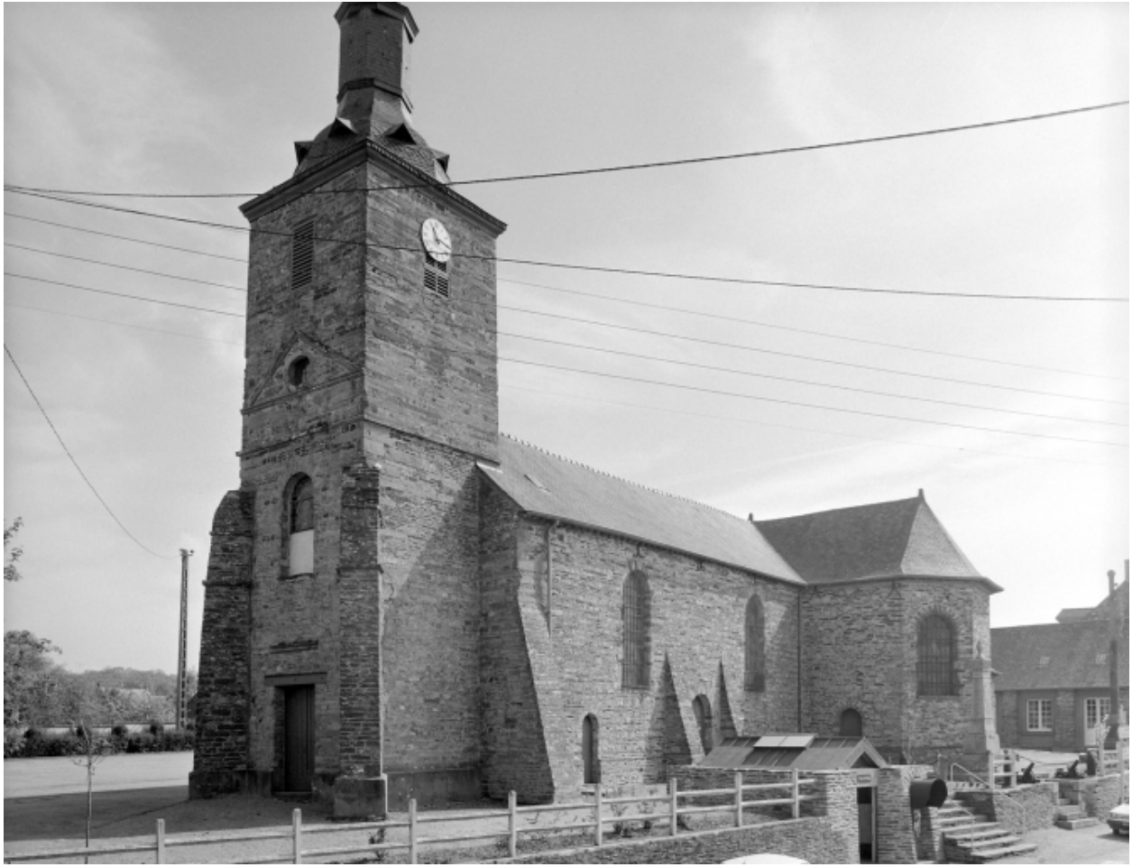
Elévation Sud-Ouest : vue générale
