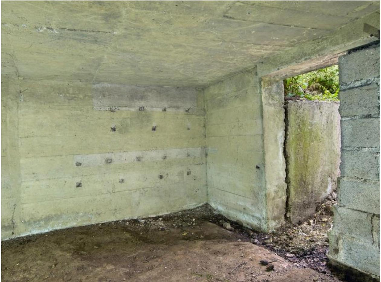
Vue de l'entrée (partiellement murée par des parpaings) de la chambre de tir. Le sol du bunker a été remblayé... Sur le mur sont visibles les traces de fixation d'une étagère murale (pour les coups de réserve ?)
