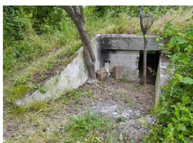
Vue de l'entrée (partiellement murée par des parpaings et remblayée) et de la rampe d'accès. Les murs latéraux protègent l'entrée. Plus on se rapproche de l'entrée, plus ils sont épais passant de 20 cm à 50 cm
