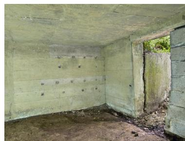
Vue de l'entrée (partiellement murée par des parpaings) de la chambre de tir. Le sol du bunker a été remblayé... Sur le mur sont visibles les traces de fixation d'une étagère murale (pour les coups de réserve ?)
