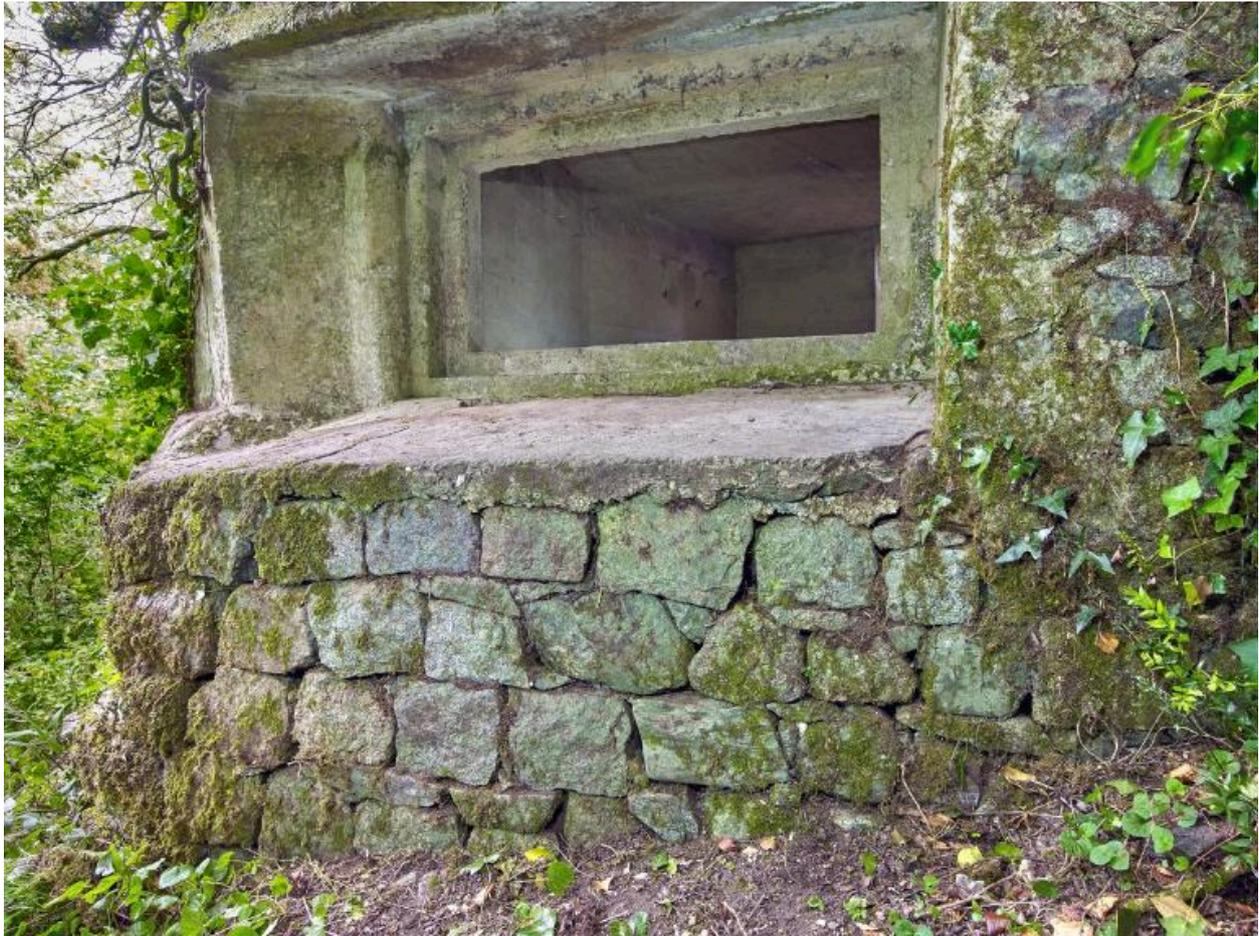
Vue de l'embrasure rectangulaire en gradin depuis l'extérieur. Le bunker est intégré dans le mur de clôture/soutènement du domaine
