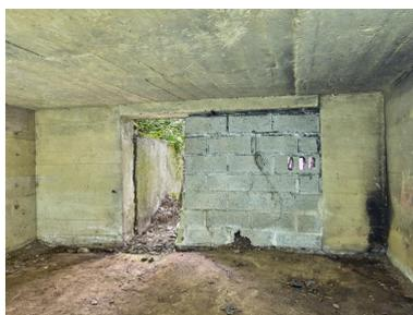
Vue de l'entrée (partiellement murée par des parpaings) de la chambre de tir. Le sol du bunker a été remblayé
