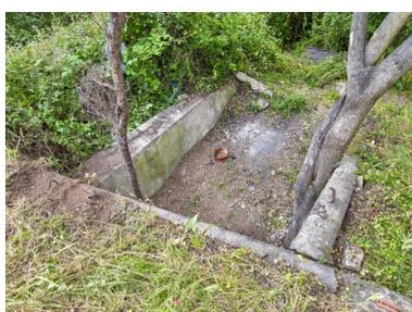
Vue de la rampe d'accès depuis la dalle de couverture. Les murs latéraux protègent l'entrée. Plus on se rapproche de l'entrée, plus ils sont épais passant de 20 cm à 50 cm
