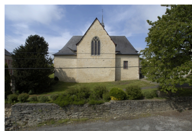
Vue est de l'église Phot. Bernard Bègne IVR53_20043500827NUCA
