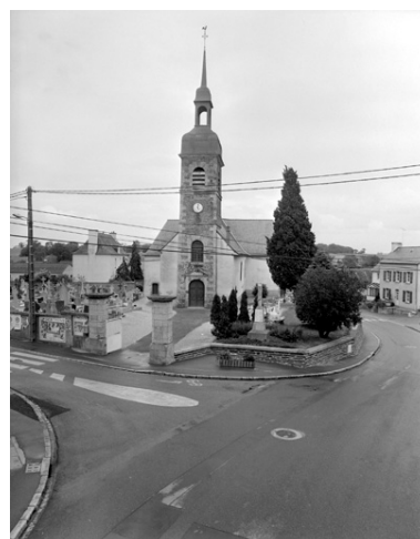
Élévation ouest : vue générale Phot. Guy Artur, Phot. Norbert Lambart IVR53_19943500918X
