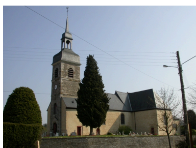
Vue sud-ouest Phot. Stéphanie Ménard IVR53_20043510862NUCA
