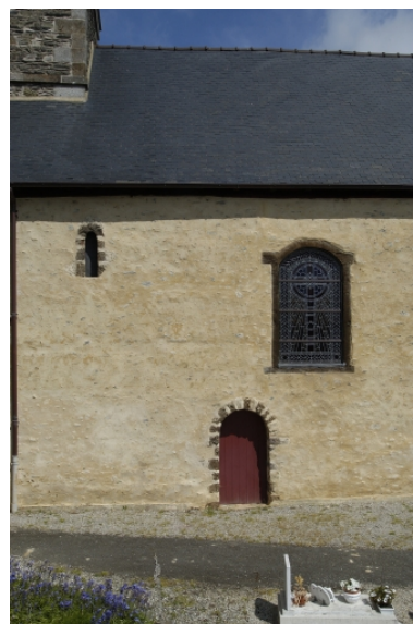
Détail des baies de la façade sud Phot. Bernard Bègne IVR53_20043500832NUCA
