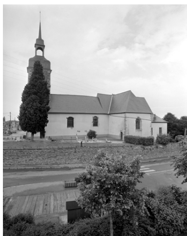
Elévation sud : vue générale Phot. Guy Artur, Phot. Norbert Lambart IVR53_19943500920X
