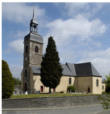
Vue générale sud-ouest Phot. Bernard Bègne IVR53_20043500830NUCA
