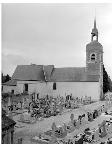
Elévation nord : vue générale Phot. Guy Artur, Phot. Norbert Lambart IVR53_19943500919X
