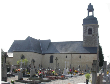
Vue nord Phot. Stéphanie Ménard IVR53_20043510863NUCA
