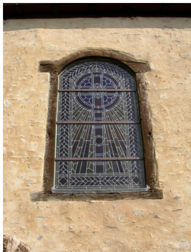
Fenêtre de la façade sud Phot. Stéphanie Ménard IVR53_20043510896NUCA
