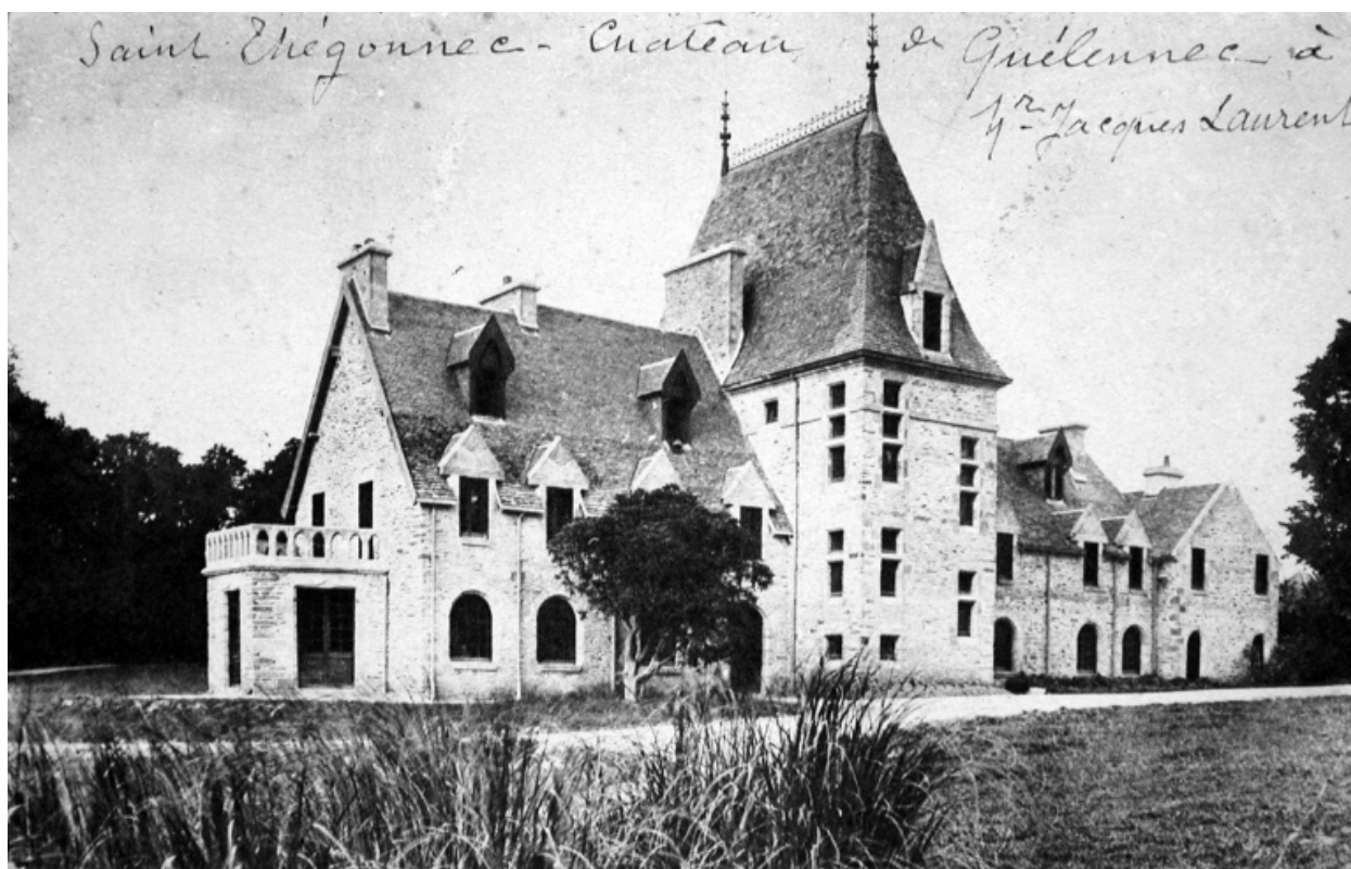
Vue générale de la façade postérieure
