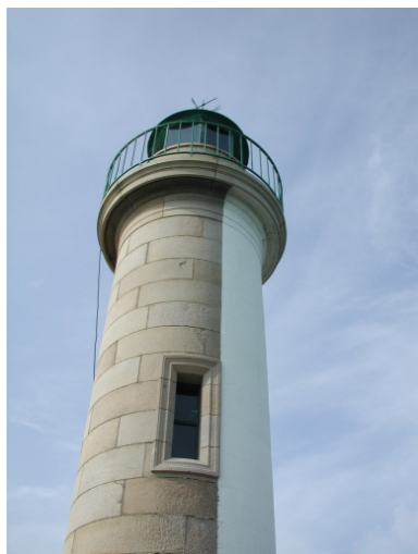
Vue de la tour de forme elliptique du fanal : remarquer le bicolorisme de la façade, l'ouverture et la lanterne sur la plateforme à encorbellement Phot. Guy Prigent IVR53_20072206004NUCA
