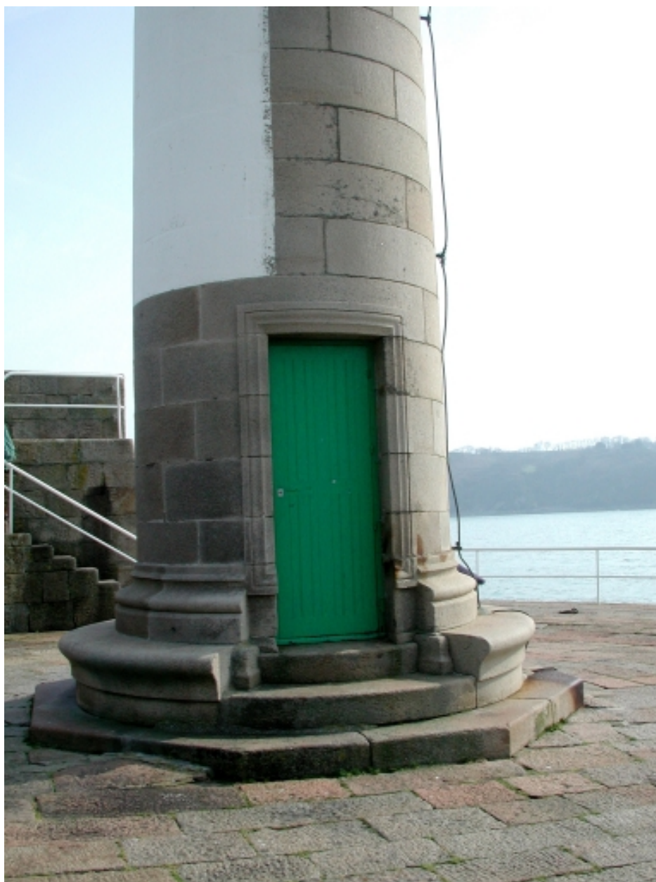
Vue de la base cylindrique très ouvragé du fanal, en pierre de taille
