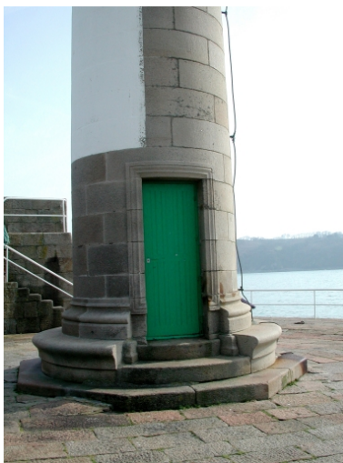
Vue de la base cylindrique très ouvragé du fanal, en pierre de taille Phot. Guy Prigent IVR53_20072206003NUCA
