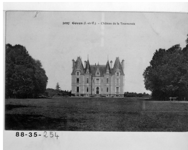
Vue de situation sur la façade principale Repro. Guy Artur, Repro. Norbert Lambart IVR53_19883500254X
