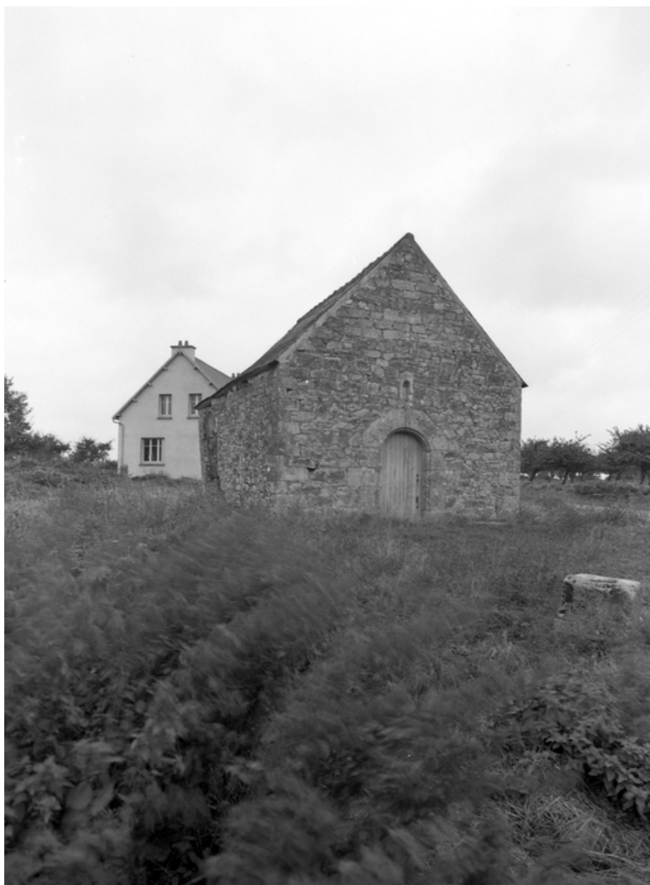
Vue générale nord ouest
