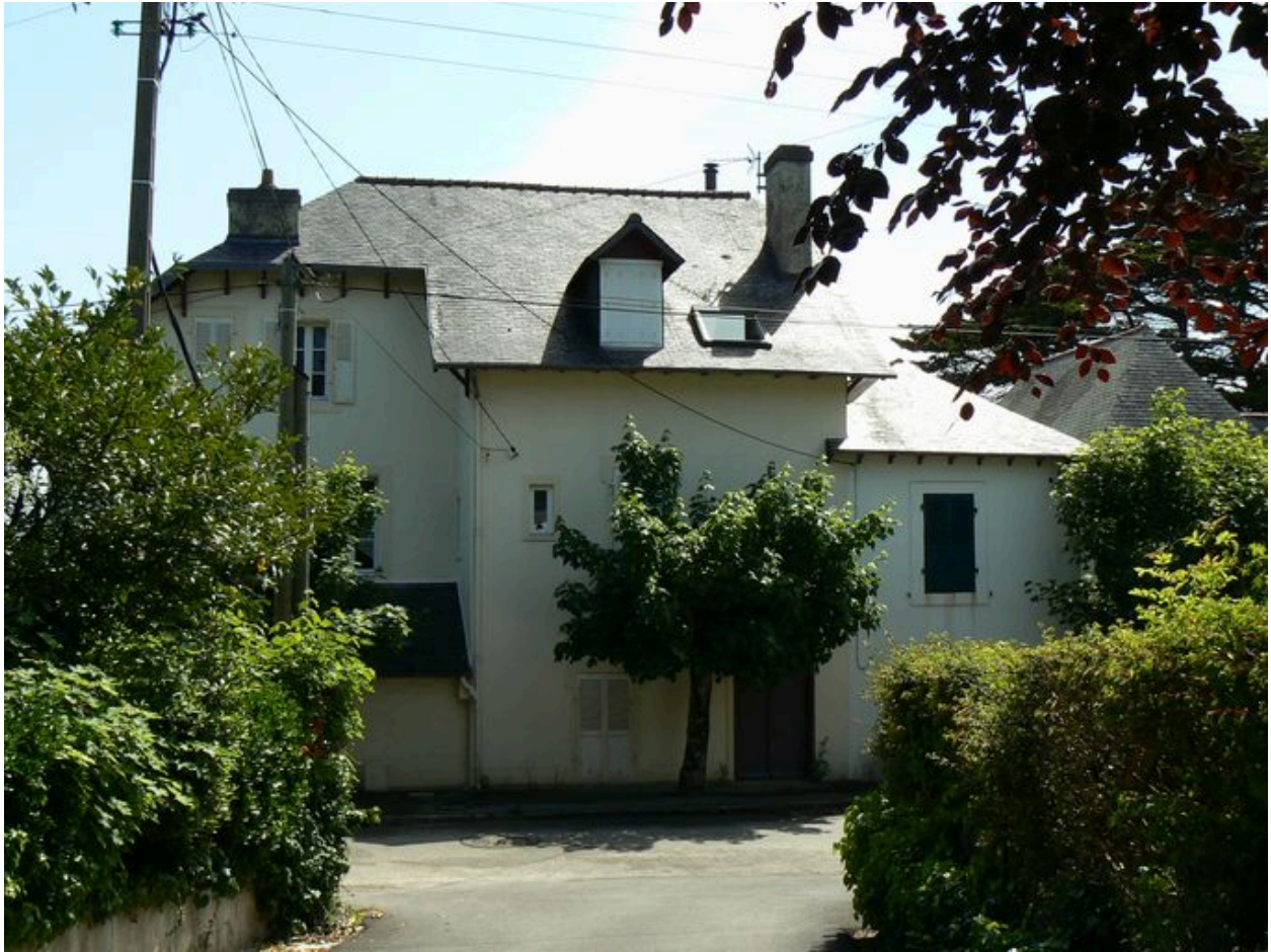
Vue de l'arrière de la villa Coquette
