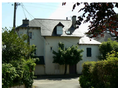
Vue de l'arrière de la villa Coquette Phot. Johan Vincent IVR53_20072908777NUCA
