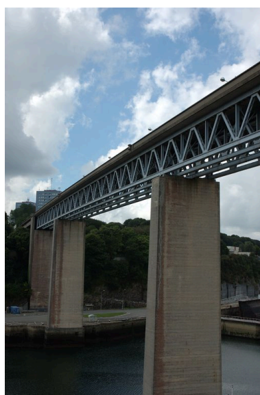
Vue du pont routier de l'Harteloire construit de 1948 à 1951 : pont en poutre en treillis, treillis type Warren Phot. Guillaume Lécueillier IVR53_20082909727NUCA
