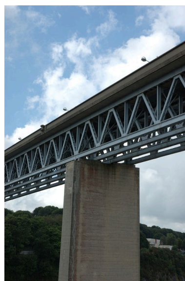
Vue du pont routier de l'Harteloire construit de 1948 à 1951 : pont en poutre en treillis, treillis type Warren Phot. Guillaume Lécueillier IVR53_20082909728NUCA
