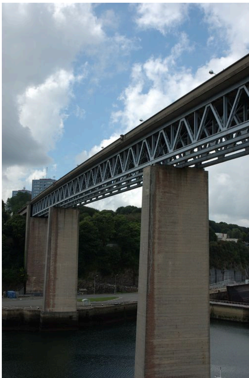
Vue du pont routier de l'Harteloire construit de 1948 à 1951 : pont en poutre en treillis, treillis type Warren
