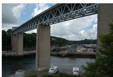
Vue du pont routier de l'Harteloire construit de 1948 à 1951 : pont en poutre en treillis, treillis type Warren Phot. Guillaume Lécueillier IVR53_20082909726NUCA
