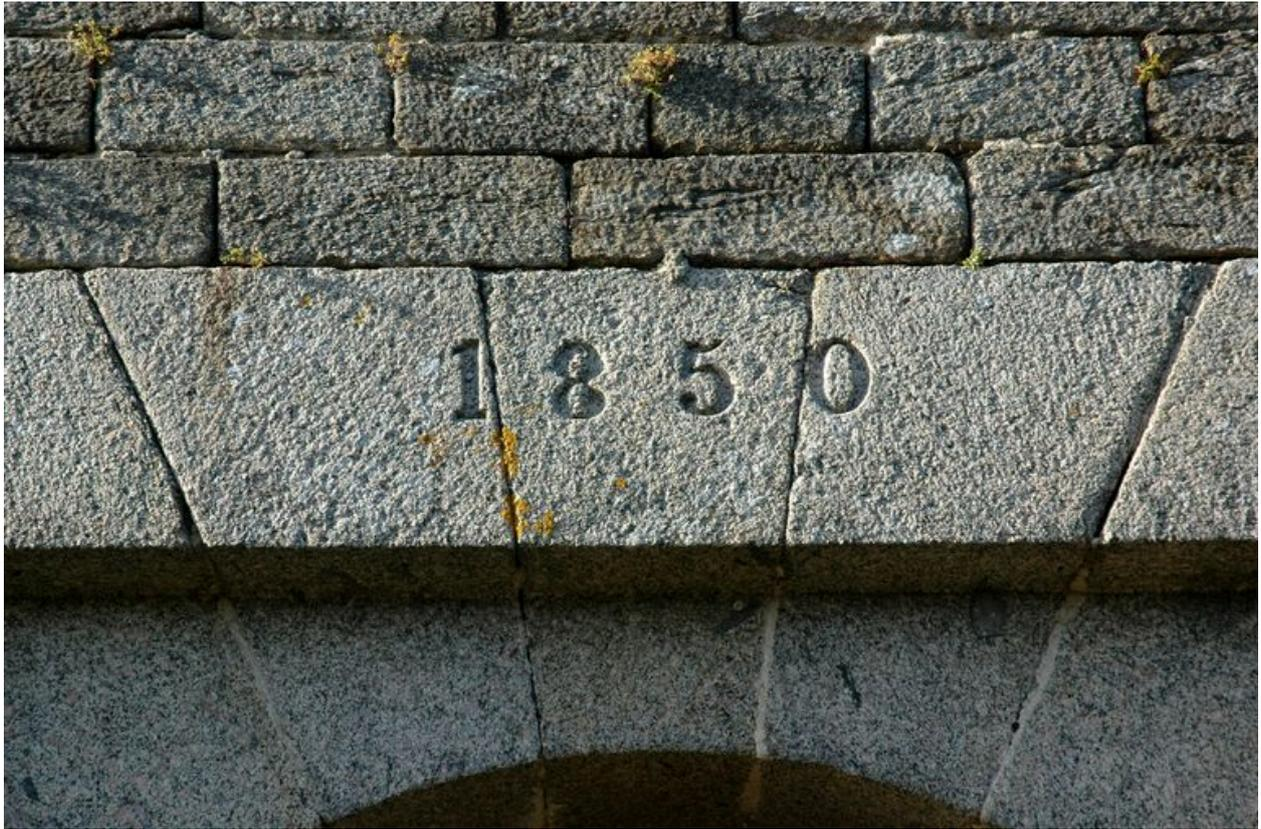
Vue du linteau en plate-bande à quatre claveaux et clé portant le millésime de construction 1850 (état en 2004)
