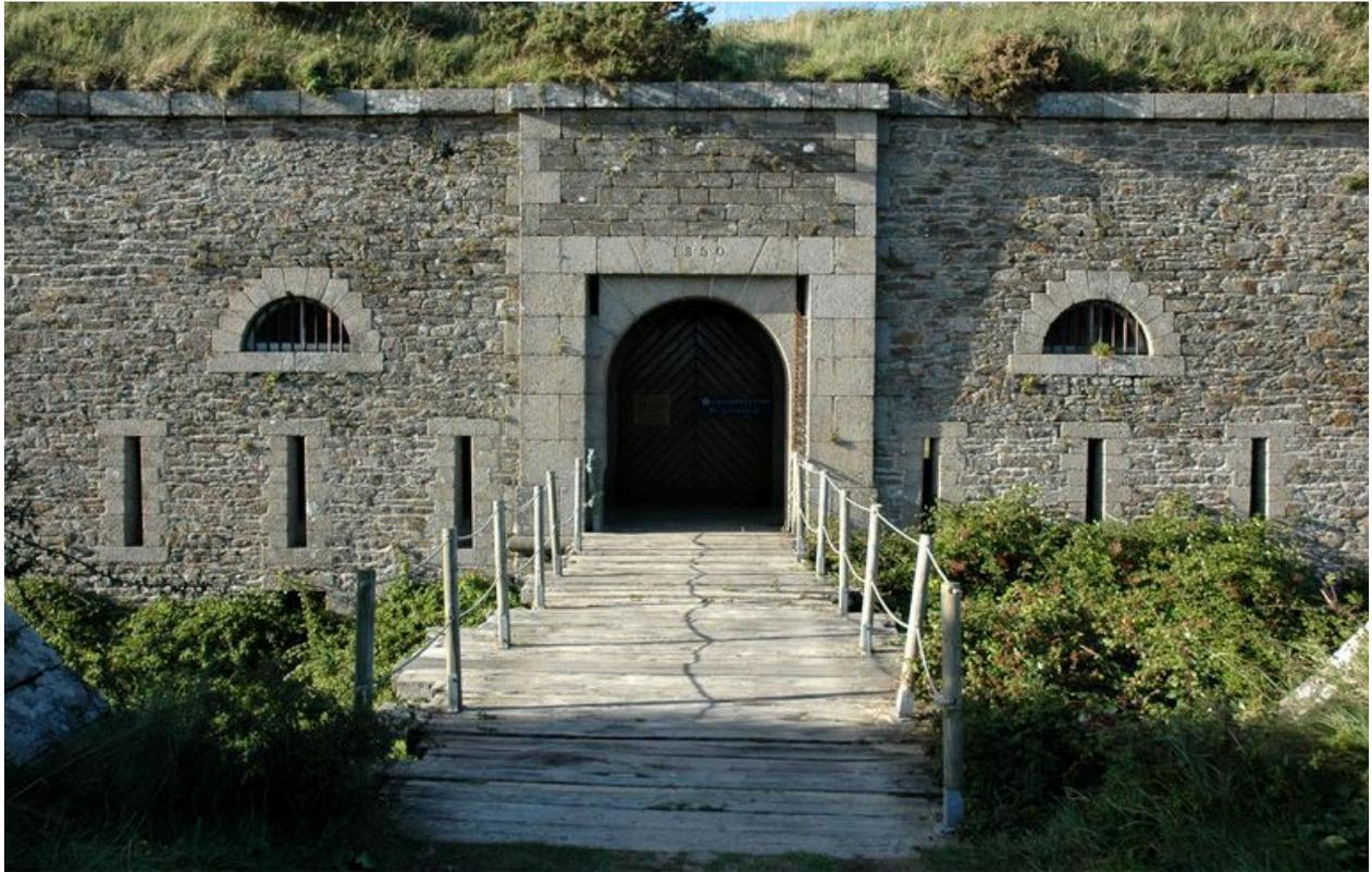
Vue de l'entrée aménagée au centre de l'escarpe sud (état en 2004). Une passerelle (à l'origine un pont-levis) permet d'enjamber le fossé. De part et d'autre de la porte sont disposés des créneaux de fusillade
