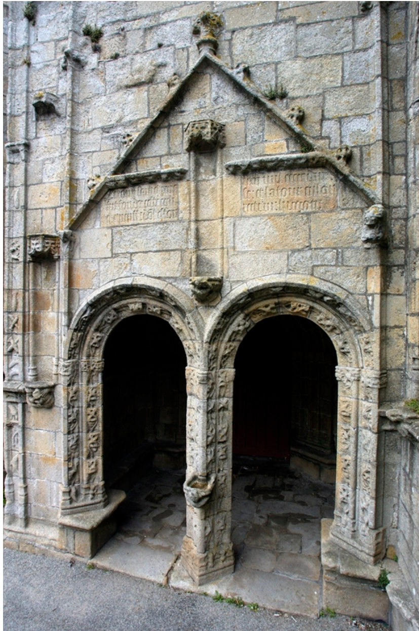
Porche sud au pied de la tour ouest
