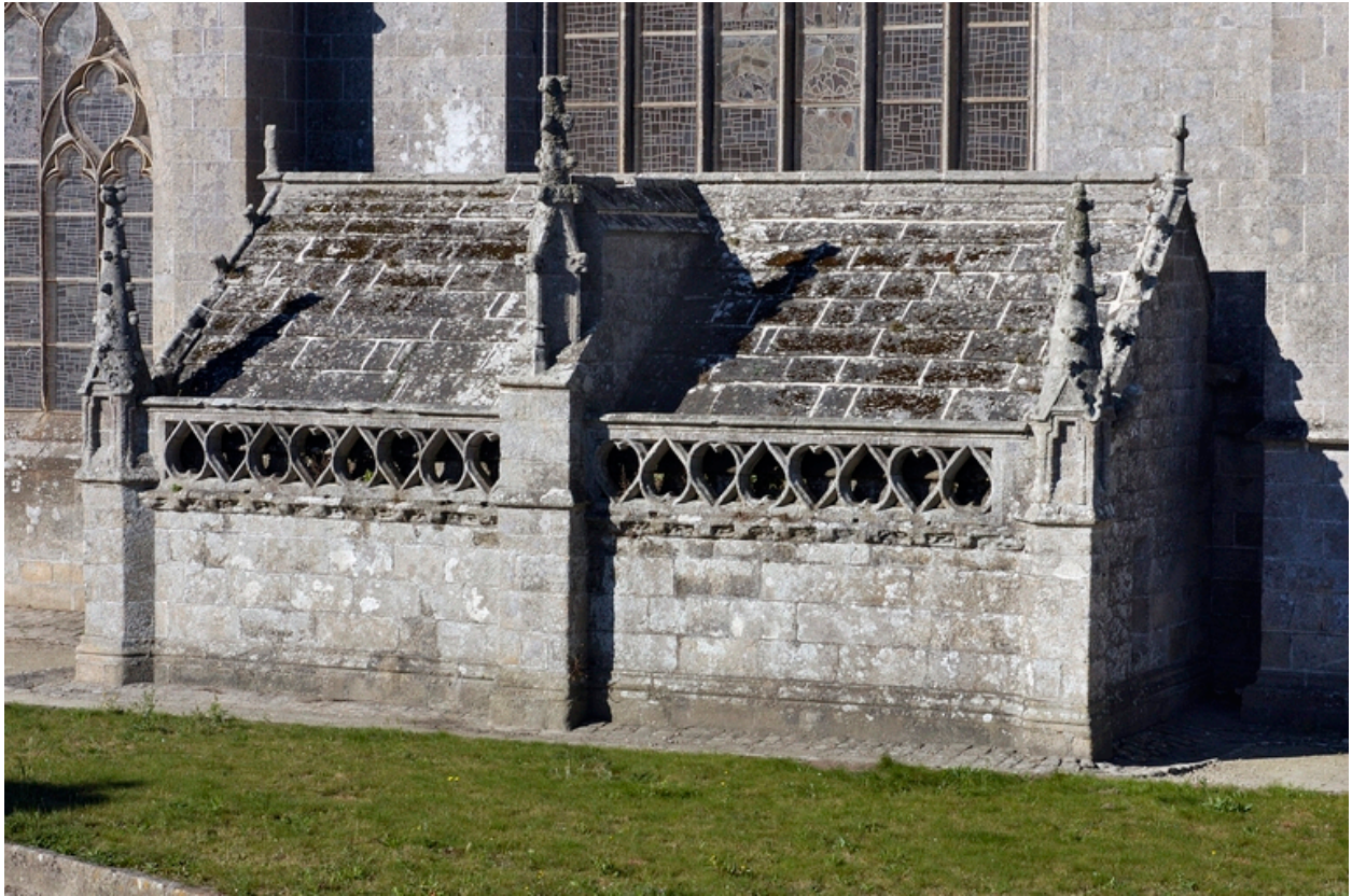
Vue de la sacristie-chambre du trésor
