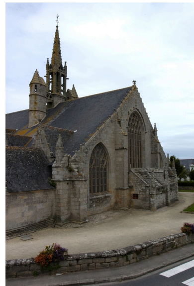
Vue biaise du chevet Phot. Norbert Lambart IVR53_20072900181NUCA
