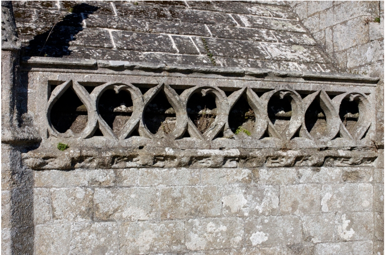
Sacristie-chambre du trésor, détail de la balustrade
