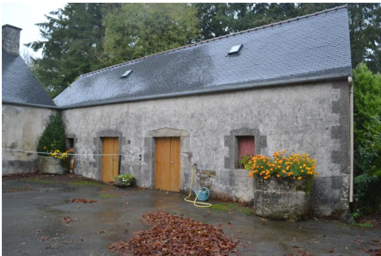
Atelier de tissage. Vue générale sud-ouest
