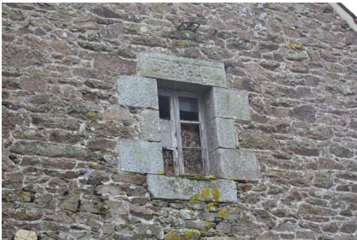
Grange, 1864. Détail de la fenêtre de l'étage
