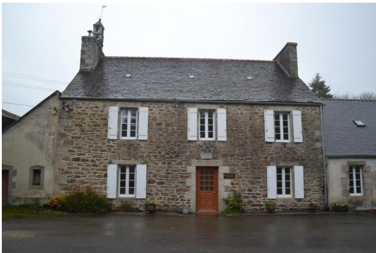
Maison d'habitation, 1852. Vue générale sud
