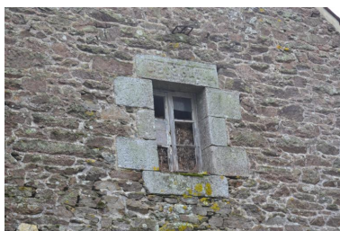
Grange, 1864. Détail de la fenêtre de l'étage IVR53_20182905928NUCA
