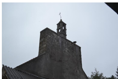
Maison d'habitation. Pignon ouest. Clocheton IVR53_20182905931NUCA
