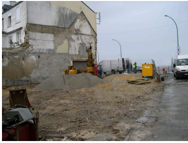
Chantier à l'emplacement de l'ancienne conserverie de sardines Béziers Phot. Guillaume Marie IVR53_20062908484NUCA
