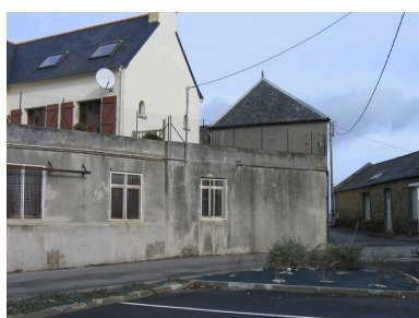
Elévation postérieure de l'ancienne conserverie Phot. Françoise Péron IVR53_20062908407NUCA
