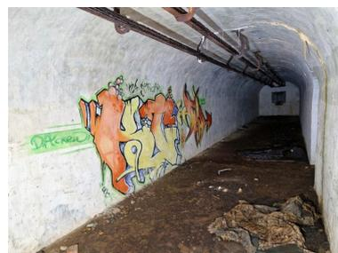
Vue intérieure du magasin à munitions : extrémité ouest, fixations et rail pour la manutention des obus via un palan. Ce graffiti est daté de 2008
