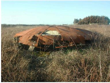
Vue du poste de télémétrie (état en 2003). Il conserve sa couverture en tôle assemblée par rivetage
