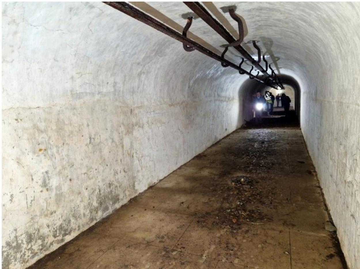
Vue intérieure du magasin à munitions : extrémité ouest, fixations et rail pour la manutention des obus via un palan.
