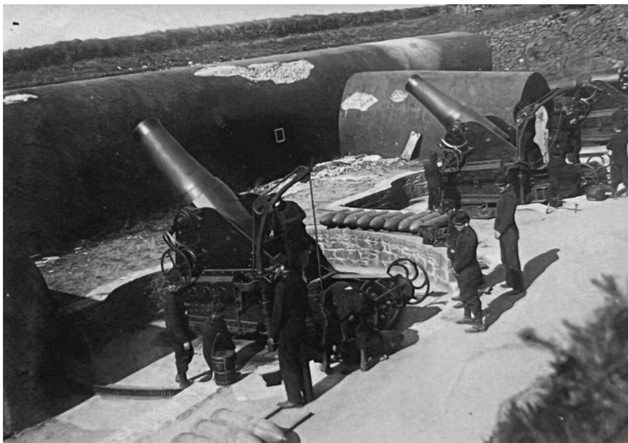
Vue d'un exercice de tir au mortier modèle 1883-T-1893 sur affûts Marine modèle 1883 à pivot antérieur modifié, non daté (collection particulière)
