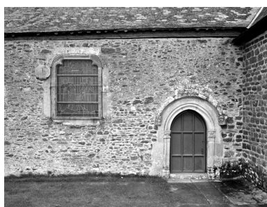
Vue partielle sud : porte et fenêtre Phot. Guy Artur, Phot. Norbert Lambart IVR53_19943500669X
