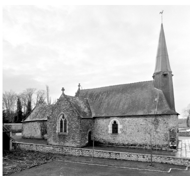
Vue générale nord Phot. Guy Artur, Phot. Norbert Lambart IVR53_19943500671X
