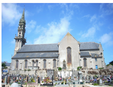
Ouessant, église paroissiale Saint-Paul-Aurélien : élévation sud Phot. Gwénaél Fauchille IVR53_20082906491NUCA
