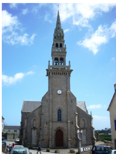
Ouessant, église paroissiale Saint-Paul-Aurélien : élévation ouest Phot. Gwénaél Fauchille
