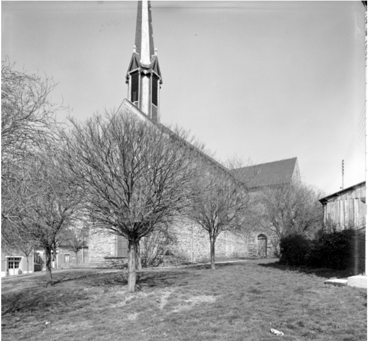
Elévation Sud-Ouest : vue générale
