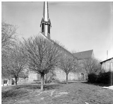
Elévation Sud-Ouest : vue générale Phot. François Dagorn IVR53_19703500349V
