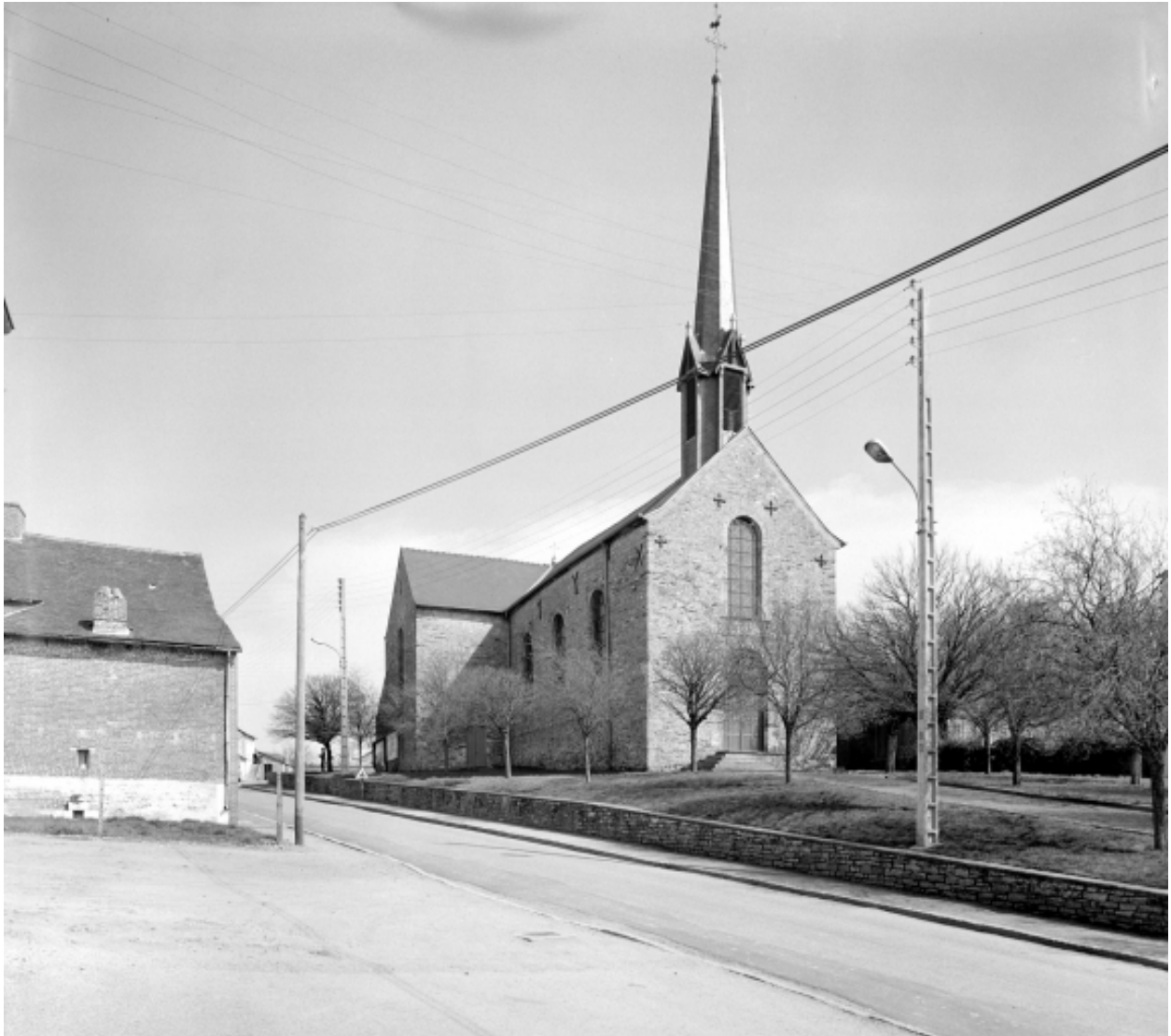
Elévation Nord-Ouest : vue générale
