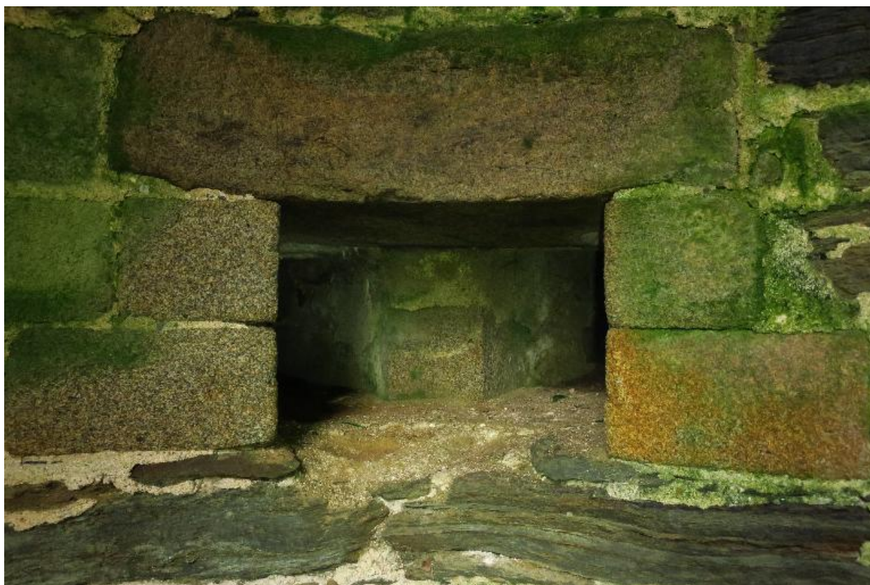
Le Palais, enceinte urbaine, réduit H, créneau de tir.
