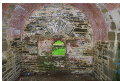
Le Palais, enceinte urbaine, réduit H, casemate d'artillerie. Phot. Lionel Duigou IVR53_20175608577NUCA
