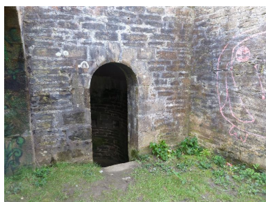
Le Palais, enceinte urbaine, réduit H, débouché de l'escalier de gauche. Phot. Patrick Jadé IVR53_20175608582NUCA
