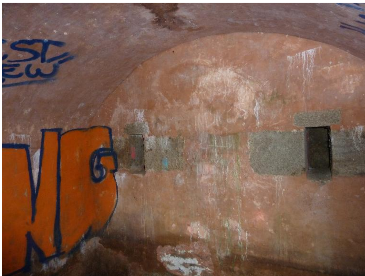
Le Palais, enceinte urbaine, réduit H, magasin à poudre.
