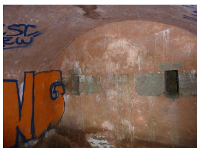
Le Palais, enceinte urbaine, réduit H, magasin à poudre. Phot. Patrick Jadé IVR53_20175608588NUCA
