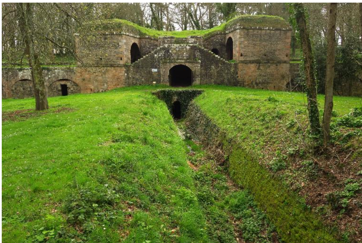
Le Palais, enceinte urbaine, réduit H, vue d'ensemble de la gorge.
