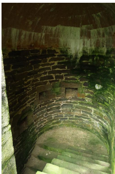
Le Palais, enceinte urbaine, réduit H, escalier de gauche. Phot. Lionel Duigou IVR53_20175608583NUCA
