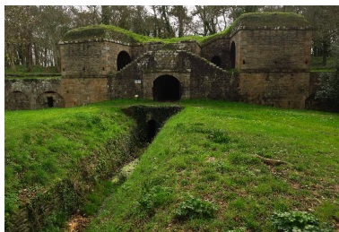
Le Palais, enceinte urbaine, réduit H, vue d'ensemble de la gorge. Phot. Lionel Duigou IVR53_20175608572NUCA
