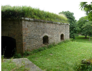
Le Palais, enceinte urbaine, réduit H, flanc gauche. Phot. Patrick Jadé IVR53_20175608575NUCA
