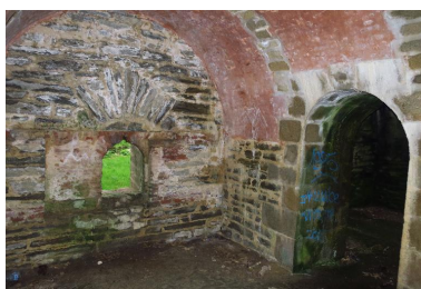
Le Palais, enceinte urbaine, réduit H, casemate d'artillerie. Phot. Lionel Duigou IVR53_20175608578NUCA
