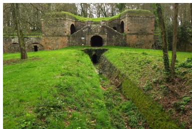
Le Palais, enceinte urbaine, réduit H, vue d'ensemble de la gorge. Phot. Lionel Duigou IVR53_20175608571NUCA
