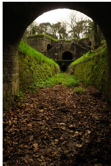
Le Palais, enceinte urbaine, réduit H, gorge vue depuis la caponnière. Phot. Lionel Duigou IVR53_20175608573NUCA
