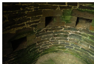
Le Palais, enceinte urbaine, réduit H, escalier de droite, détail. Phot. Lionel Duigou IVR53_20175608584NUCA
