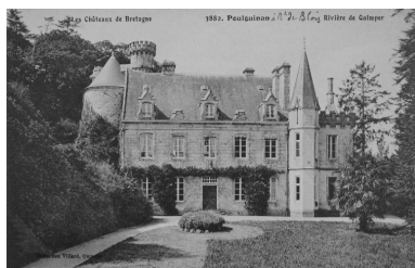
Vue générale de la façade ouest Phot. Elise Lauranceau, Autr. Villard IVR53_20032902755NUCB
