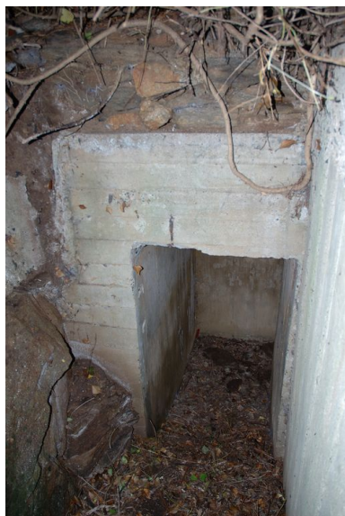
Vue d'un ensemble fortifié de la Presqu'île de Kermorvan constitué d'un Tobrouk pour mortier de 80 mm, tranchée bétonnée et abri Phot. Guillaume Lécueillier IVR53_20082910119NUCA
