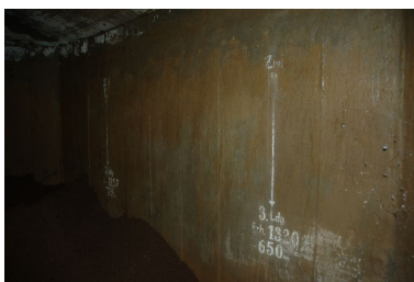
Vue d'un ensemble fortifié de la Presqu'île de Kermorvan constitué d'un Tobrouk pour mortier de 80 mm, tranchée bétonnée et abri : marquage allemand Phot. Guillaume Lécueillier IVR53_20082910111NUCA
