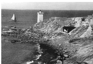
Vue générale de la pointe de Kermorvan pendant la Seconde Guerre Mondiale Phot. Guillaume Lécueillier IVR53_20022902879NUCA
