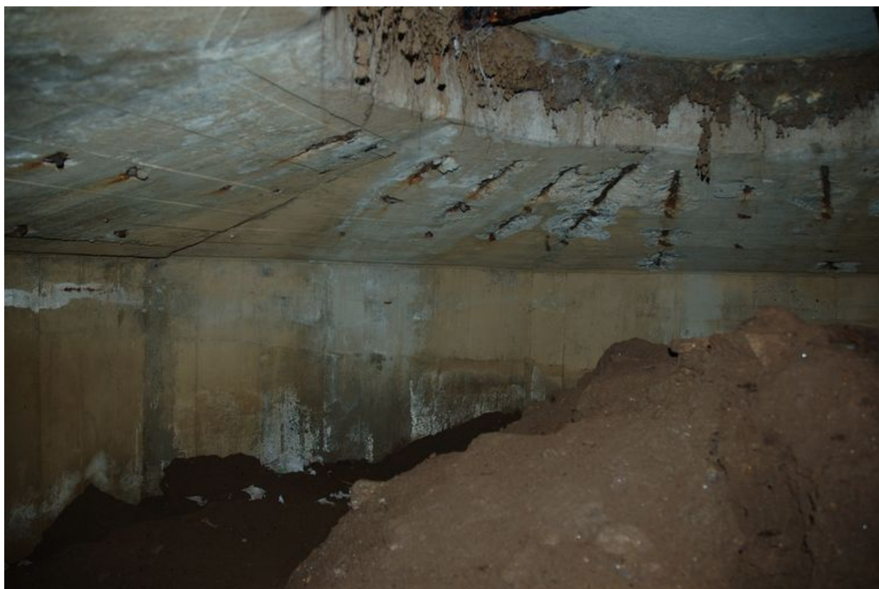
Vue d'un ensemble fortifié de la Presqu'île de Kermorvan constitué d'un Tobrouk pour mortier de 80 mm, tranchée bétonnée et abri : marquage allemand
