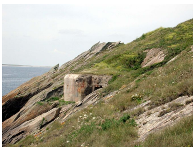
Vue générale de la casemate de type 505 pour un canon de 47 mm Skoda Pak 36 Phot. Guillaume Lécueillier IVR53_20042904227NUCA
