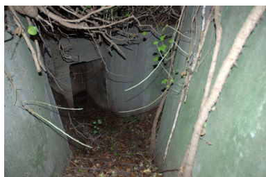
Vue d'un ensemble fortifié de la Presqu'île de Kermorvan constitué d'un Tobrouk pour mortier de 80 mm, tranchée bétonnée et abri Phot. Guillaume Lécueillier IVR53_20082910125NUCA
