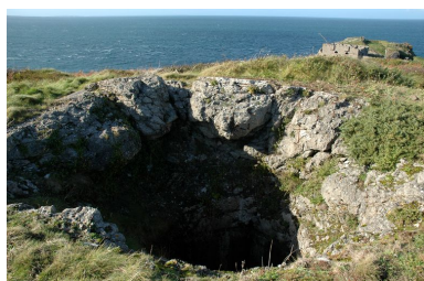
Vue de l'emplacement de la cloche blindée de l'abir type 648. En arrière- plan, le fort de l'îlette (19e siècle) Phot. Guillaume Lécueillier IVR53_20042904194NUCA
