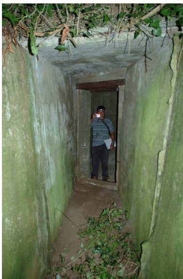
Vue d'un ensemble fortifié de la Presqu'île de Kermorvan constitué d'un Tobrouk pour mortier de 80 mm, tranchée bétonnée et abri Phot. Guillaume Lécueillier IVR53_20082910120NUCA
