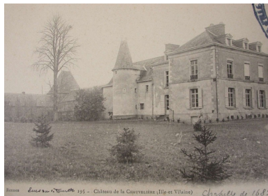
Le château de la Chauvelière sur une carte postale du début du 20e siècle Phot. Sabrina Dalibard IVR53_20043510898NUCA
