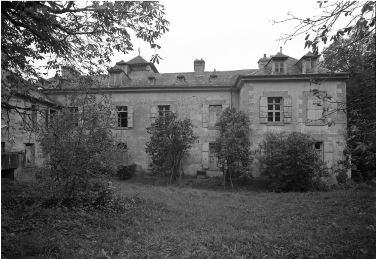
Elévation nord, vue générale.
