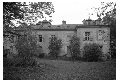
Élévation nord, vue générale. Phot. Guy Artur IVR53_19673500091V
