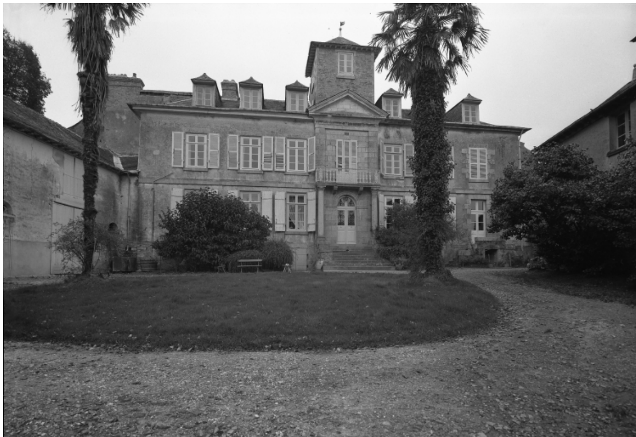
Elévation sud, vue générale.
