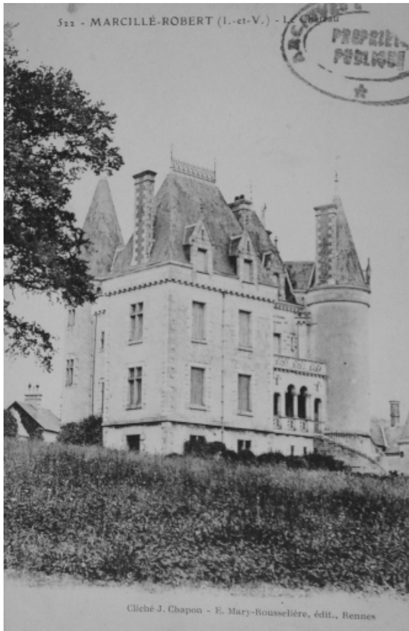
Vue générale de la façade postérieure
