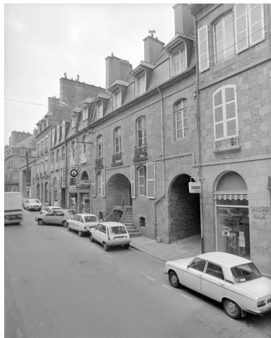
Elévation antérieure, vue générale. Phot. Guy Artur IVR53_19783500249X
