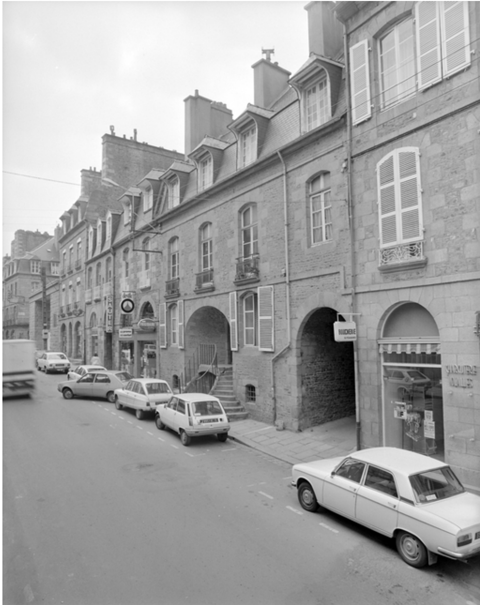
Elévation antérieure, vue générale.
