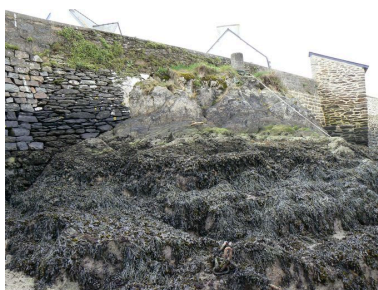
Perré entre le Quai de Kernabat et le Quai Neuf Phot. Julien Amghar IVR53_20082908602NUCA
