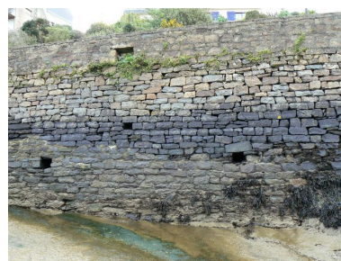
Vue générale d'un perré photographié de l'estran Phot. Julien Amghar IVR53_20082908603NUCA
