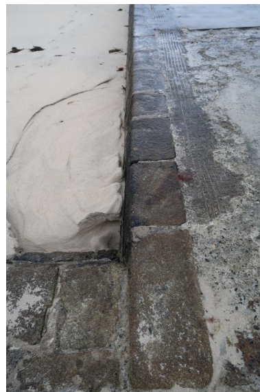
Ancienne digue de Sainte- Evette, platelage, pierres de taille Phot. Erwana L'Haridon IVR53_20212905671NUCA
