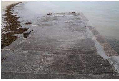
Ancienne digue de Sainte-Evette, vers le musoir, dalle béton, pierres de taille Phot. Erwana L'Haridon IVR53_20212905672NUCA
