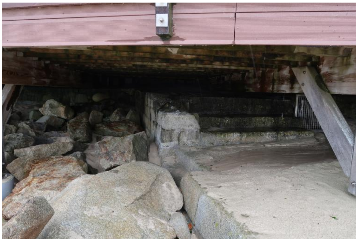
Ancienne digue de Sainte-Evette, vestige des escaliers accédant à l'embarcadère
