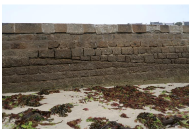
Ancienne digue de Sainte- Evette, détail de maçonnerie : trace du comblement de la cale Phot. Erwana L'Haridon IVR53_20212905665NUCA
