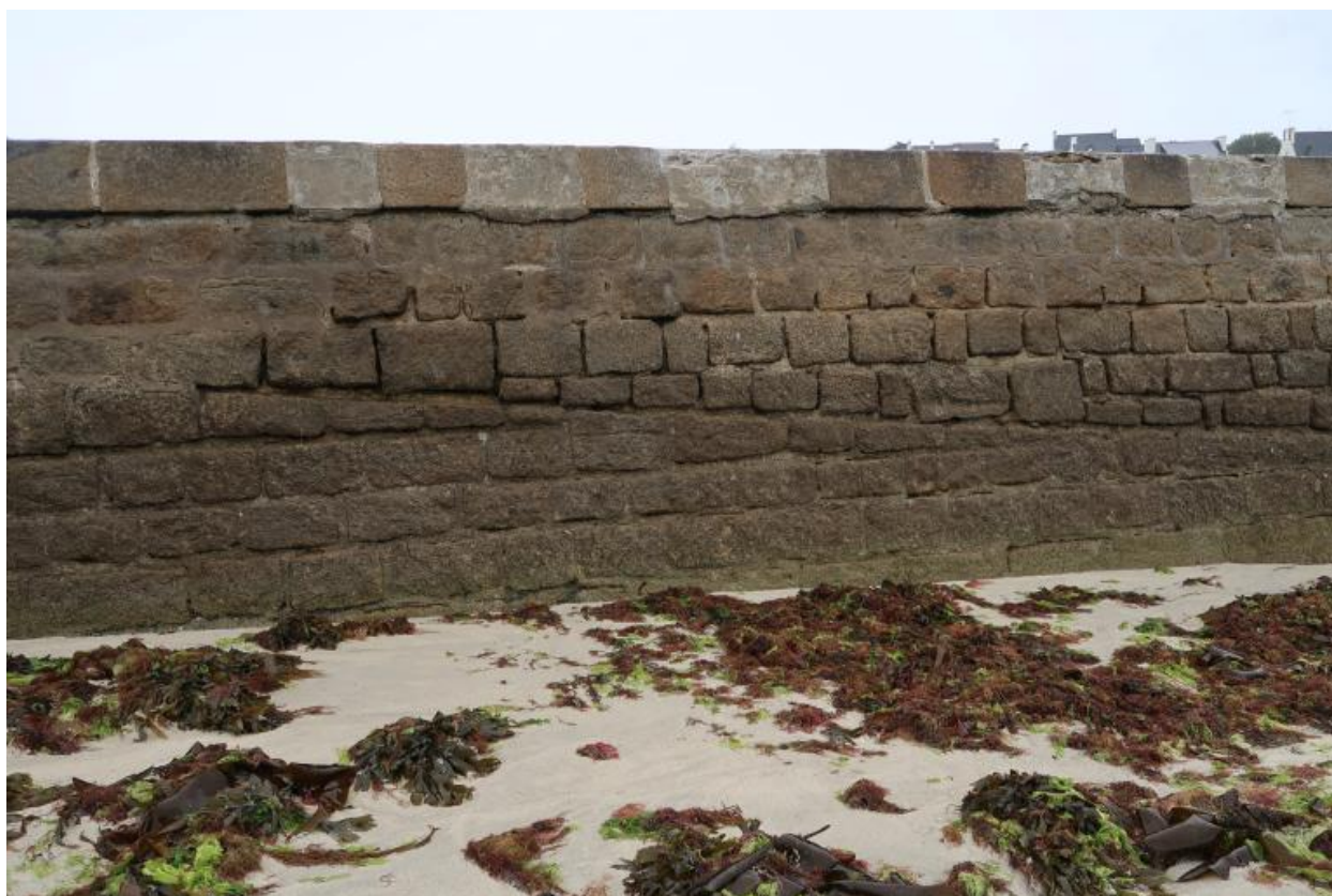
Ancienne digue de Sainte-Evette, détail de maçonnerie : trace du comblement de la cale
