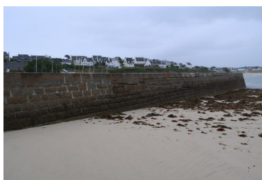
Ancienne digue de Sainte- Evette, mur maçonné et trace de la mise à niveau du platelage Phot. Erwana L'Haridon IVR53_20212905667NUCA
