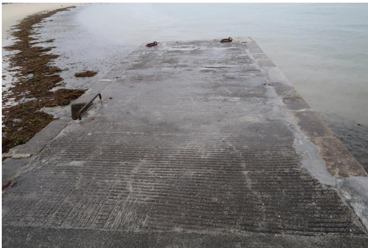
Ancienne digue de Sainte-Evette, vers le musoir, dalle béton, pierres de taille
