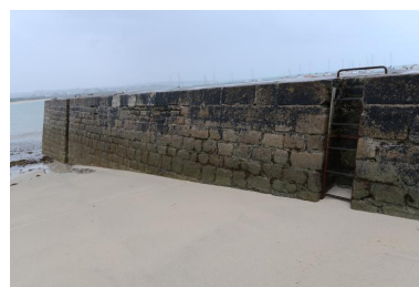
Ancienne digue de Sainte- Evette, côté nord, échelles Phot. Erwana L'Haridon IVR53_20212905669NUCA
