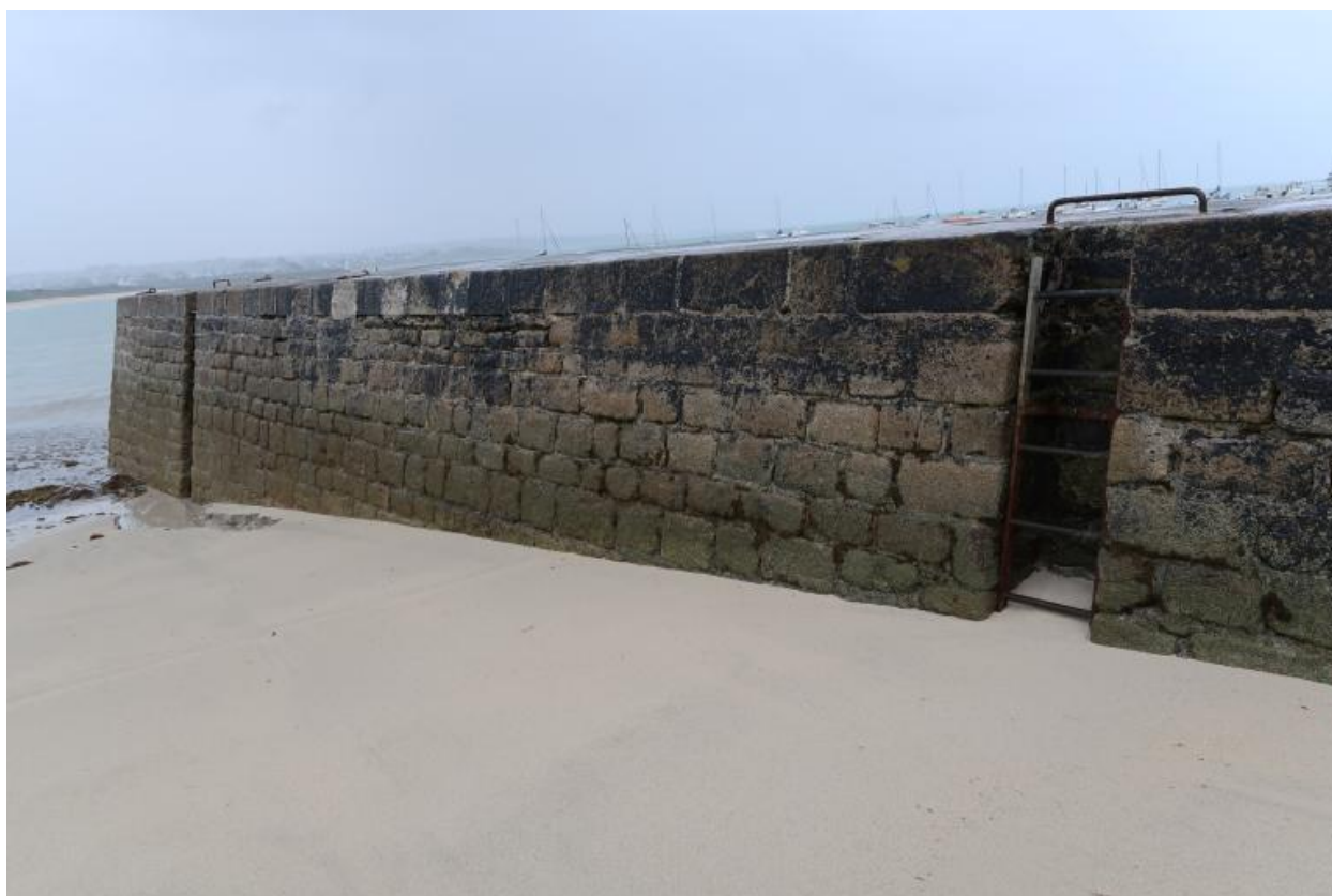
Ancienne digue de Sainte-Evette, côté nord, échelles
