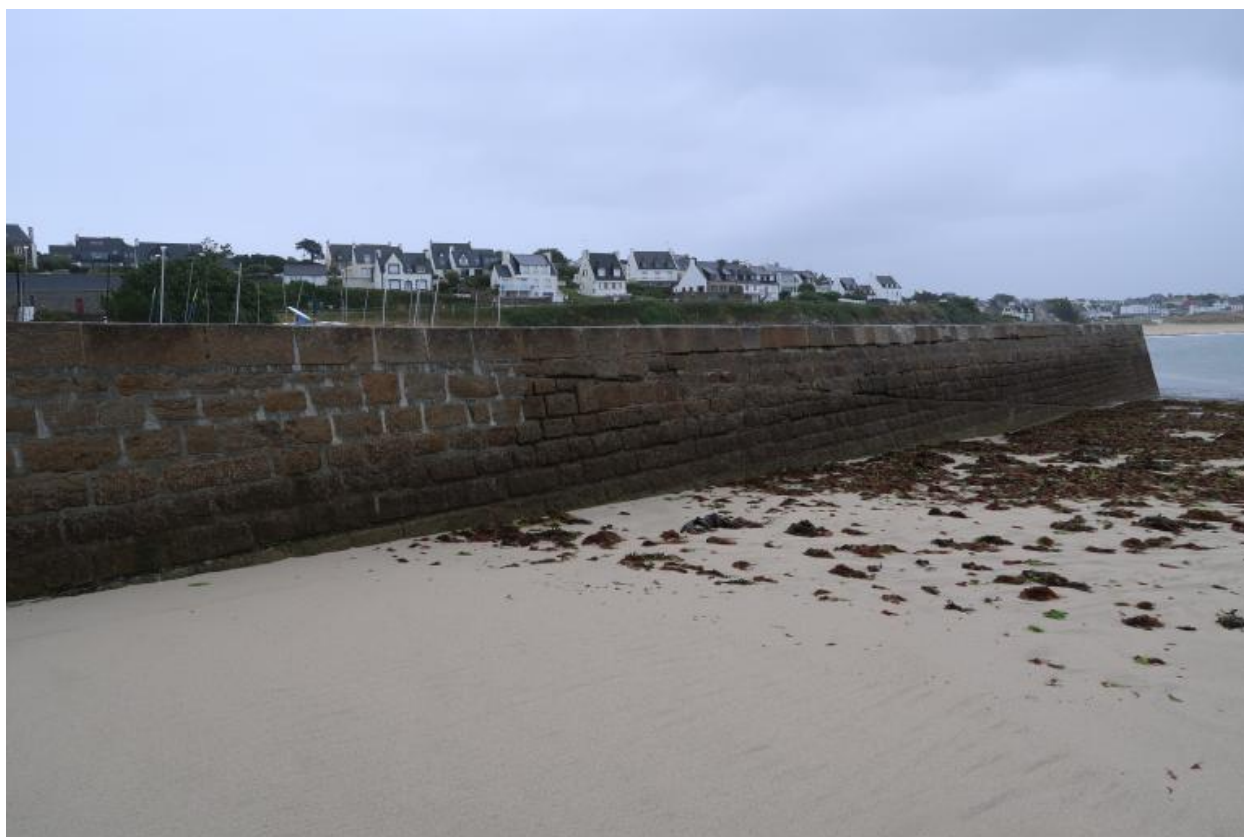
Ancienne digue de Sainte-Evette, mur maçonné et trace de la mise à niveau du platelage
