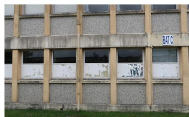
Détail de la trame du bâtiment des classes, en façade des ateliers : poteaux et poutres en béton armée, en saillie. Fenêtres basculantes à armature bois. Allèges en panneaux préfabriqués de béton recouverts de carreaux de grès. Péron et Weisbein, architectes, 1967-1968.
