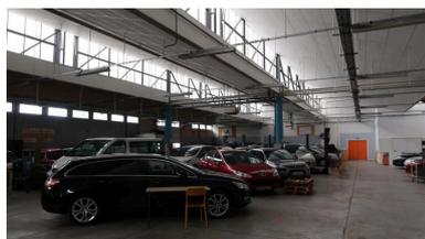
Atelier automobile, installé dans les ateliers originels du lycée. Noter la toiture à armature métallique et sheds. Péron et Weisbein, architectes, 1967-1968.
