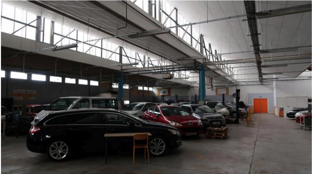
Atelier automobile, installé dans les ateliers originels du lycée. Noter la toiture à armature métallique et sheds. Péron et Weisbein, architectes, 1967-1968.
